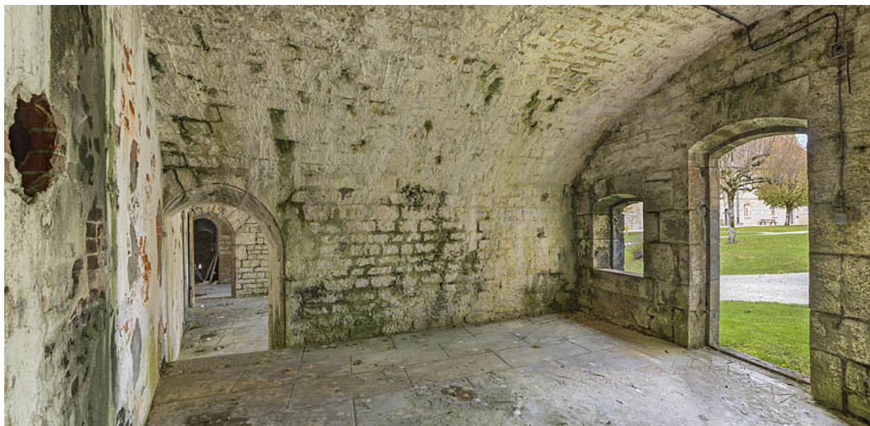
Fort Saint-André : pièce casematée.
