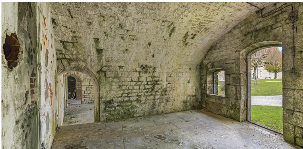
Fort Saint-André : pièce casematée.
