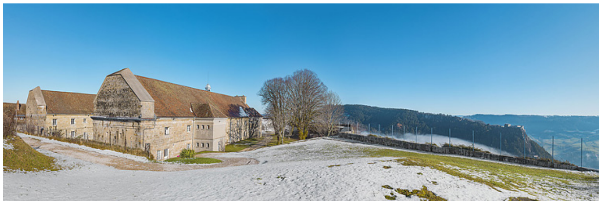
Fort Saint-André : les casernes.
