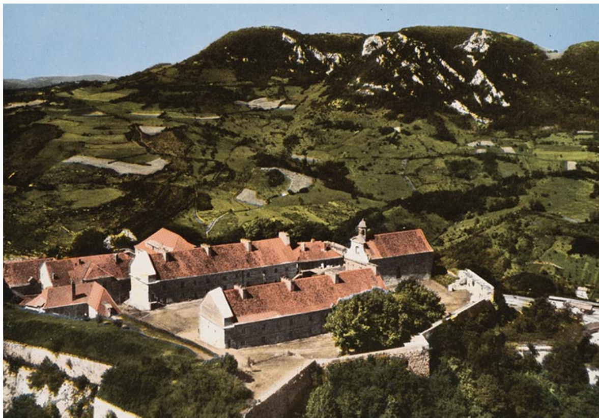
Salins-les-Bains. Vue aérienne des casernes et de la chapelle du fort Saint-André. S.d. 39, Salins-les-Bains
