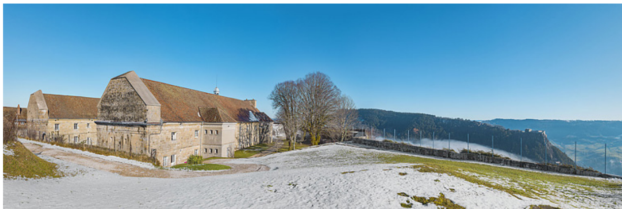
Fort Saint-André : les casernes.
