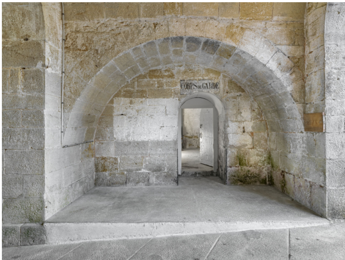
Pavillon d'entrée : porte du petit corps de garde.
