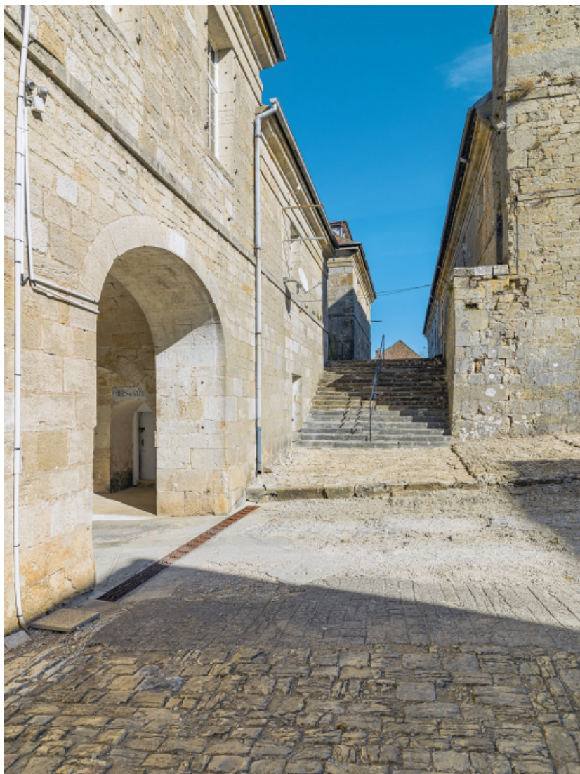
De gauche à droite : pavillon d'entrée et son passage voûté, volée de marches menant au logement du gouverneur et caserne U. 39, Salins-les-Bains chemin du Fort Saint-André, lieudit : Fort Saint-André
