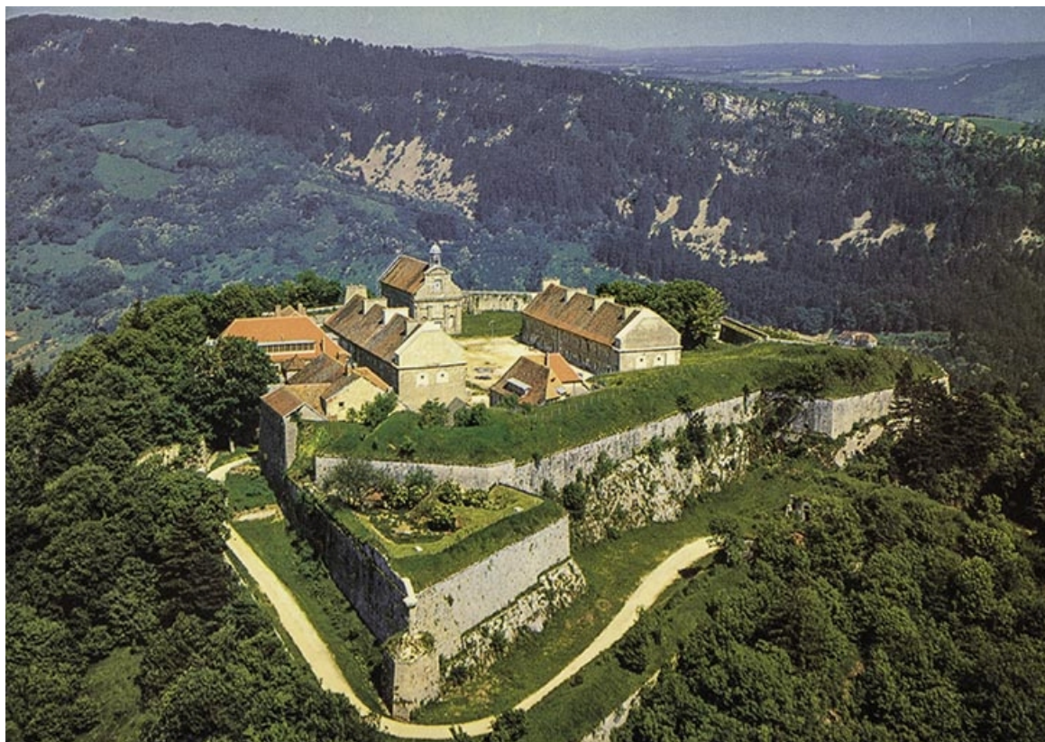
Salins-les-Bains (Jura). Vue aérienne du fort Saint-André. S.d.
