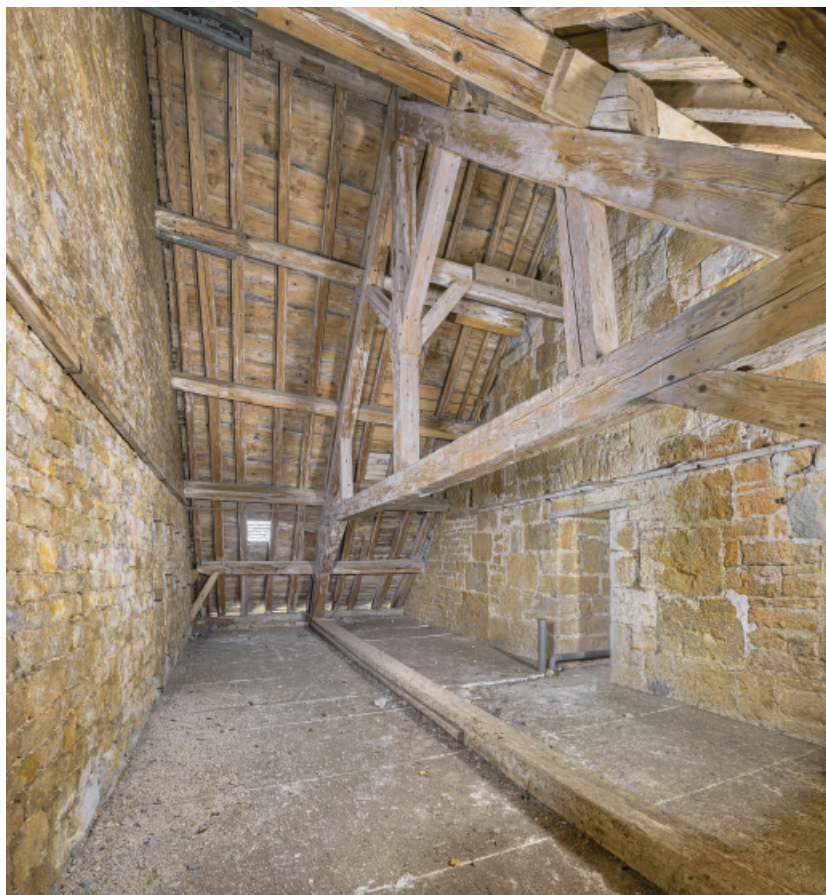
Caserne U : détail d'une ferme de la charpente.
