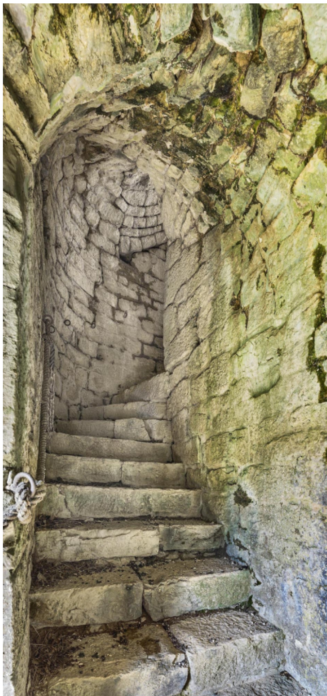
Réduit du nid d'aigle : escalier.
