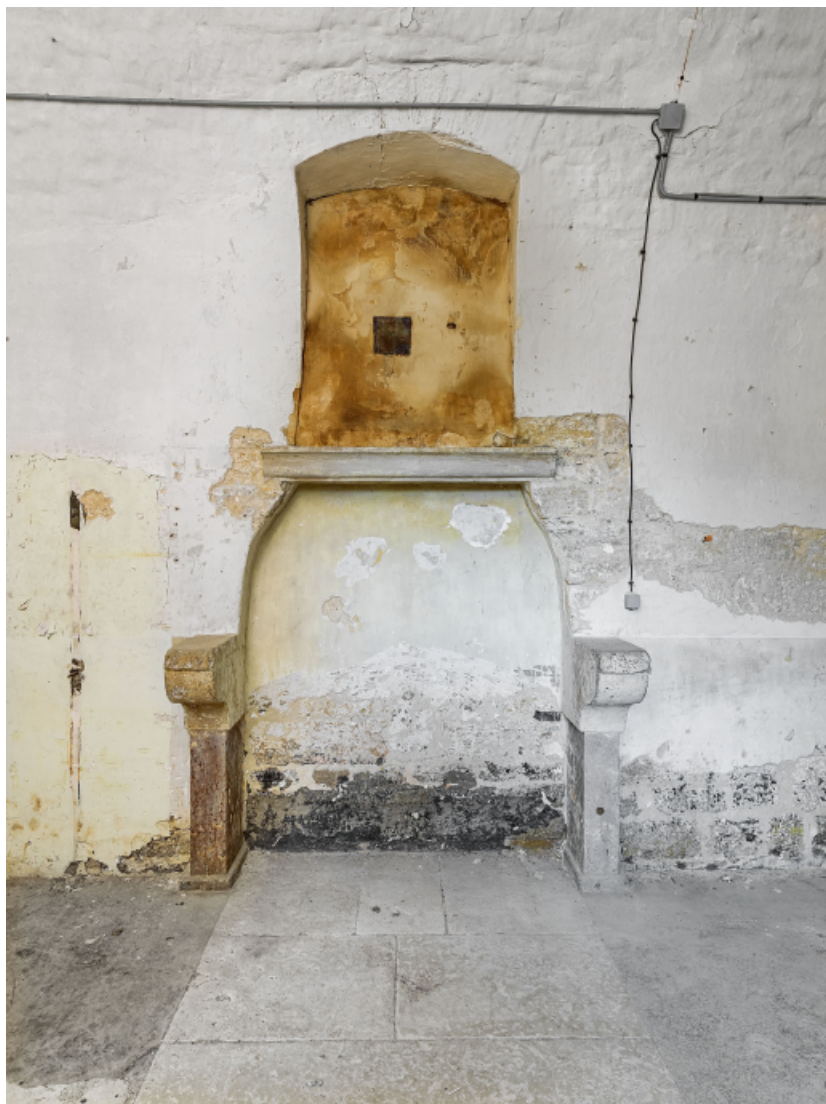
Pavillon d'entrée : cheminée de la pièce du petit corps de garde.
