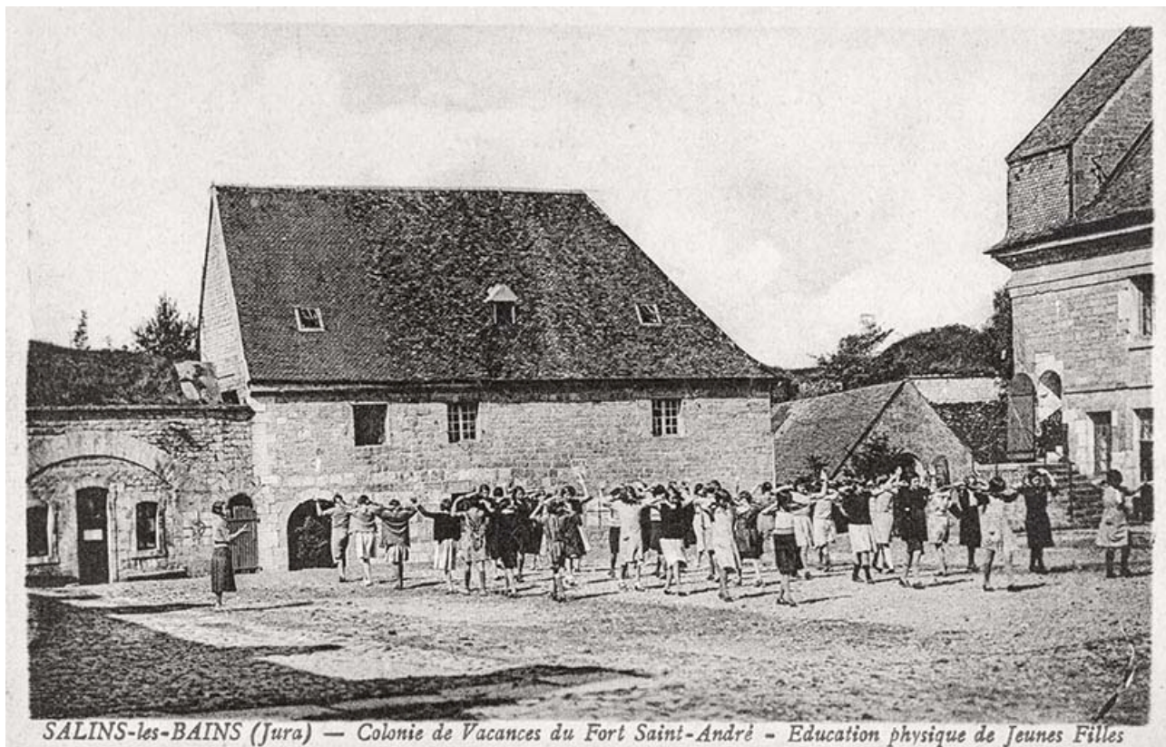
Salins-les-Bains (Jura). Colonie de Vacances du Fort Saint-André [le bâtiment abritant la salle d'armes de l'artillerie]. S.d. 39, Salins-les-Bains chemin du Fort Saint-André, lieudit : Fort Saint-André
