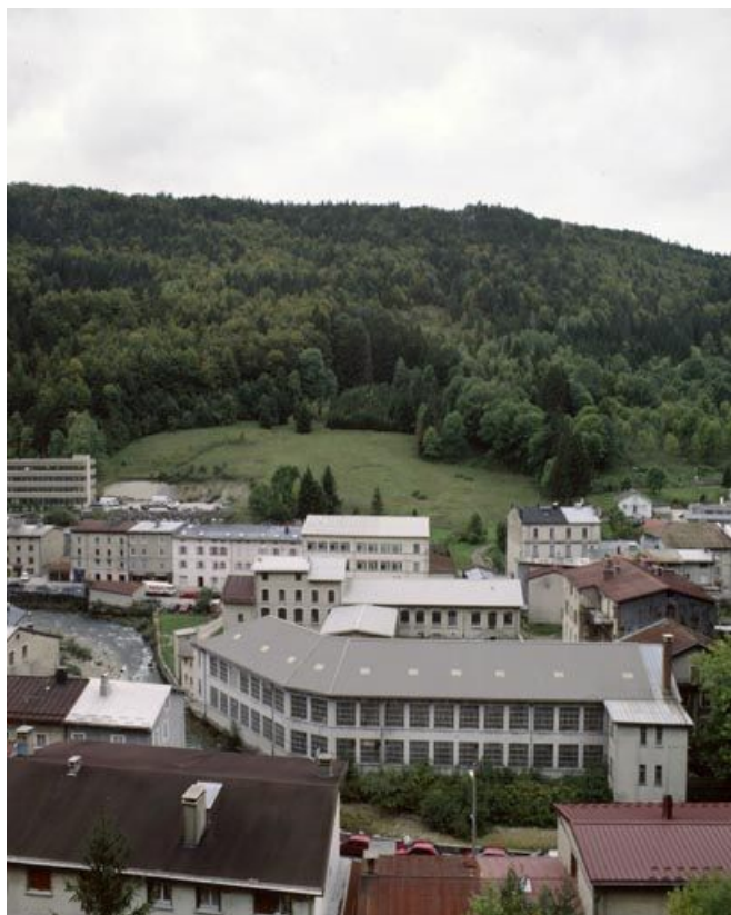
Usine de la Manufacture mécanique de Lunetterie et d'Optique (199 rue de la République), avant sa destruction. À l'arrière-plan, au centre l'ancienne usine de la Société des Lunetiers (194 à 198 rue de la République) et à gauche l'extrémité d'un bâtiment de la société lunetière L'Amy (216 à 220 de la même rue).
