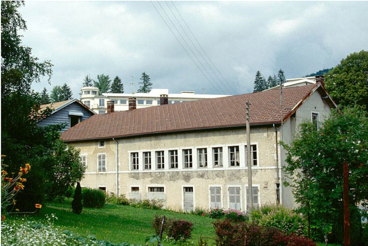
Vue d'ensemble de la façade postérieure.
