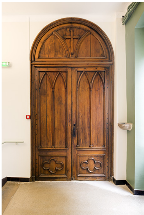
Internat : porte palière.
