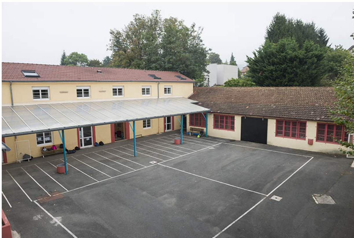
Externat - cafétéria : vue des façades sur cour.
