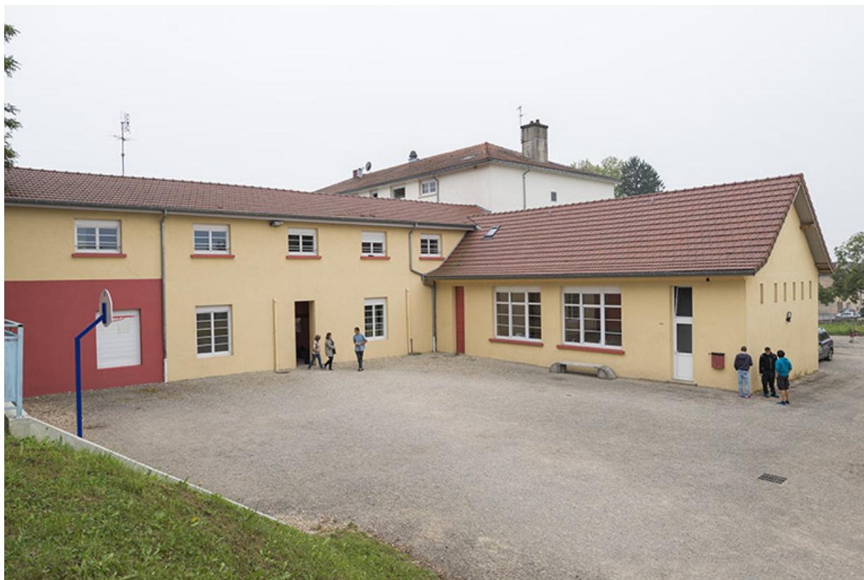
Externat : vue 3/4 de l'espace cafétéria.
