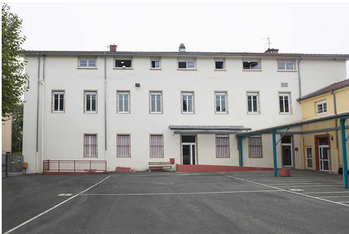
Internat : façade postérieure.
