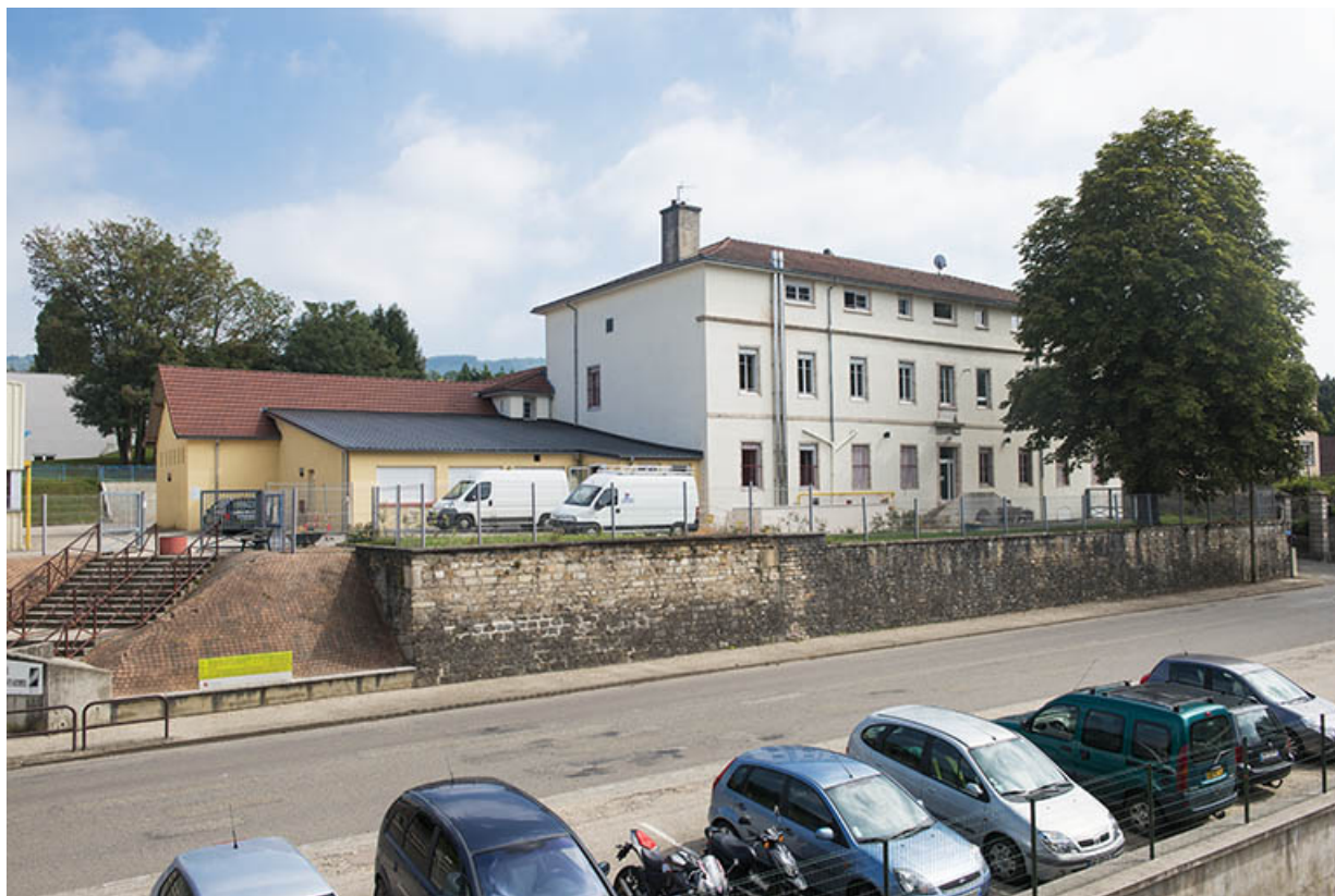
Internat : façade antérieure sur rue Lamartine.
