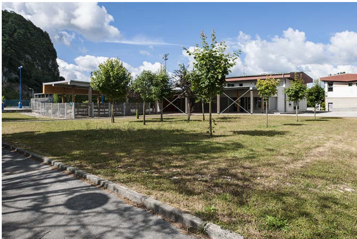
Entrée : préau avec abri pour cycles, vue postérieure.
