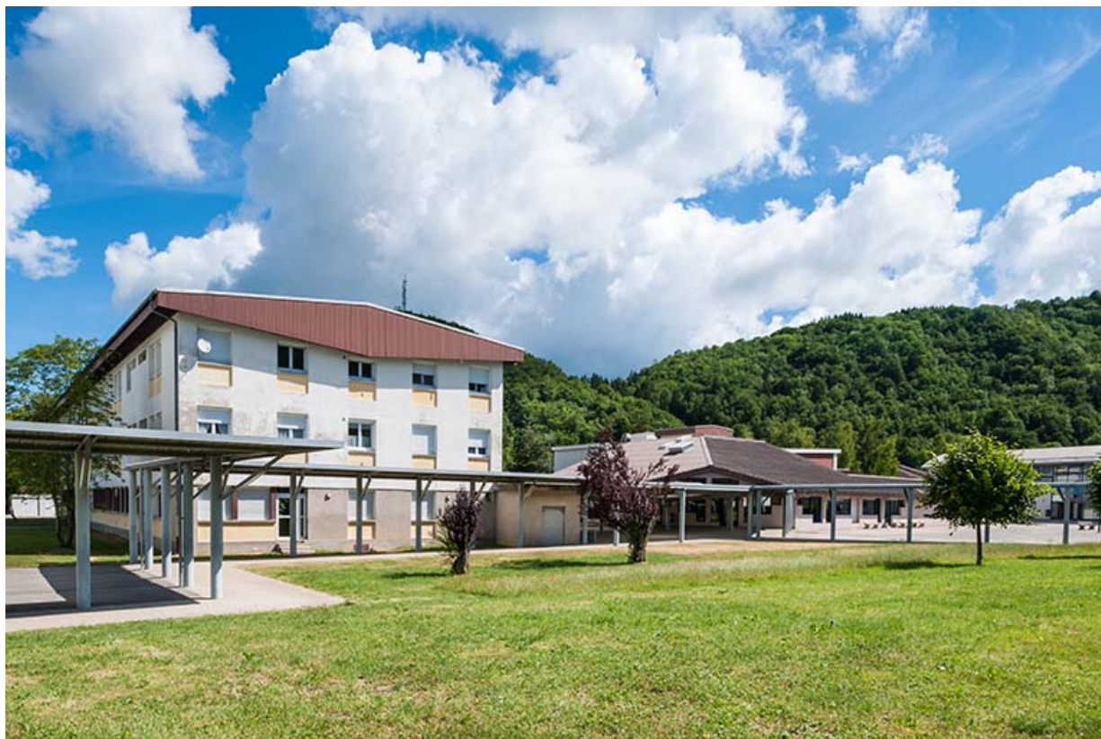
Internat à gauche (pignon sud) et bâtiment restauration à droite.
