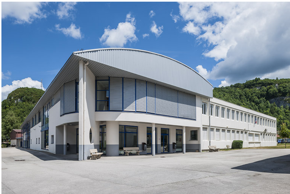
Ateliers, vue de trois quart de la façade antérieure et de la façade Sud.
