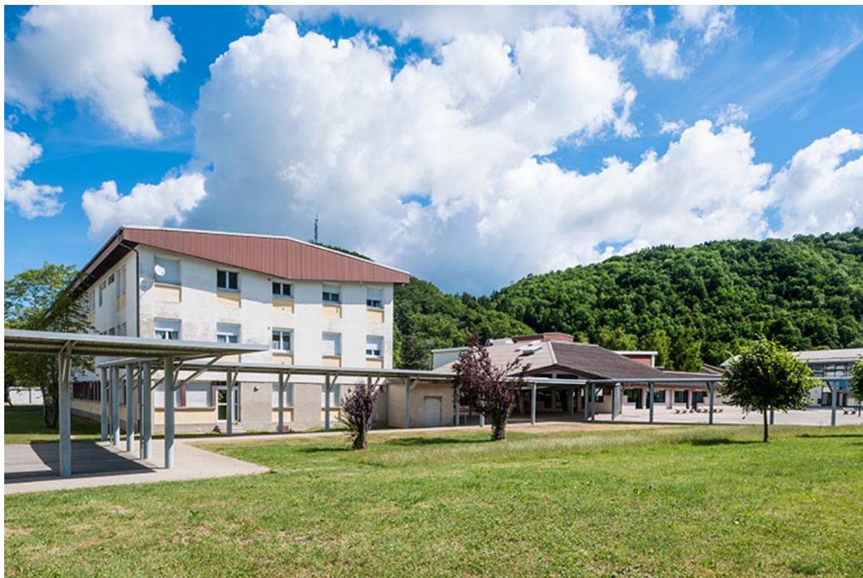
Internat et restauration : circulations couvertes. 39, Moirans-en-Montagne, 6 route de Saint-Laurent
