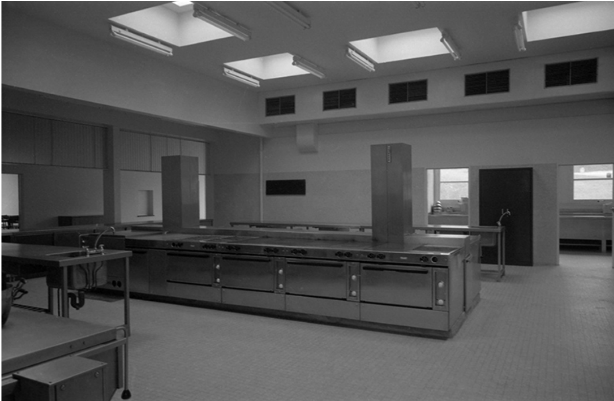
Vue intérieure des cuisines, s.d. [vers 1965].
