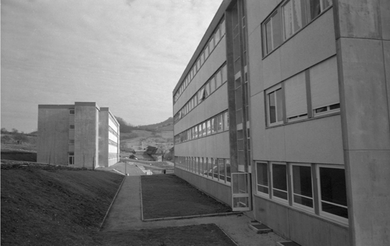
Les internats filles (à gauche) et garçons (à droite), s.d. [vers 1965]. 39, Salins-les-Bains route d' Ornans, lieudit : Margillens du Bas-Est
