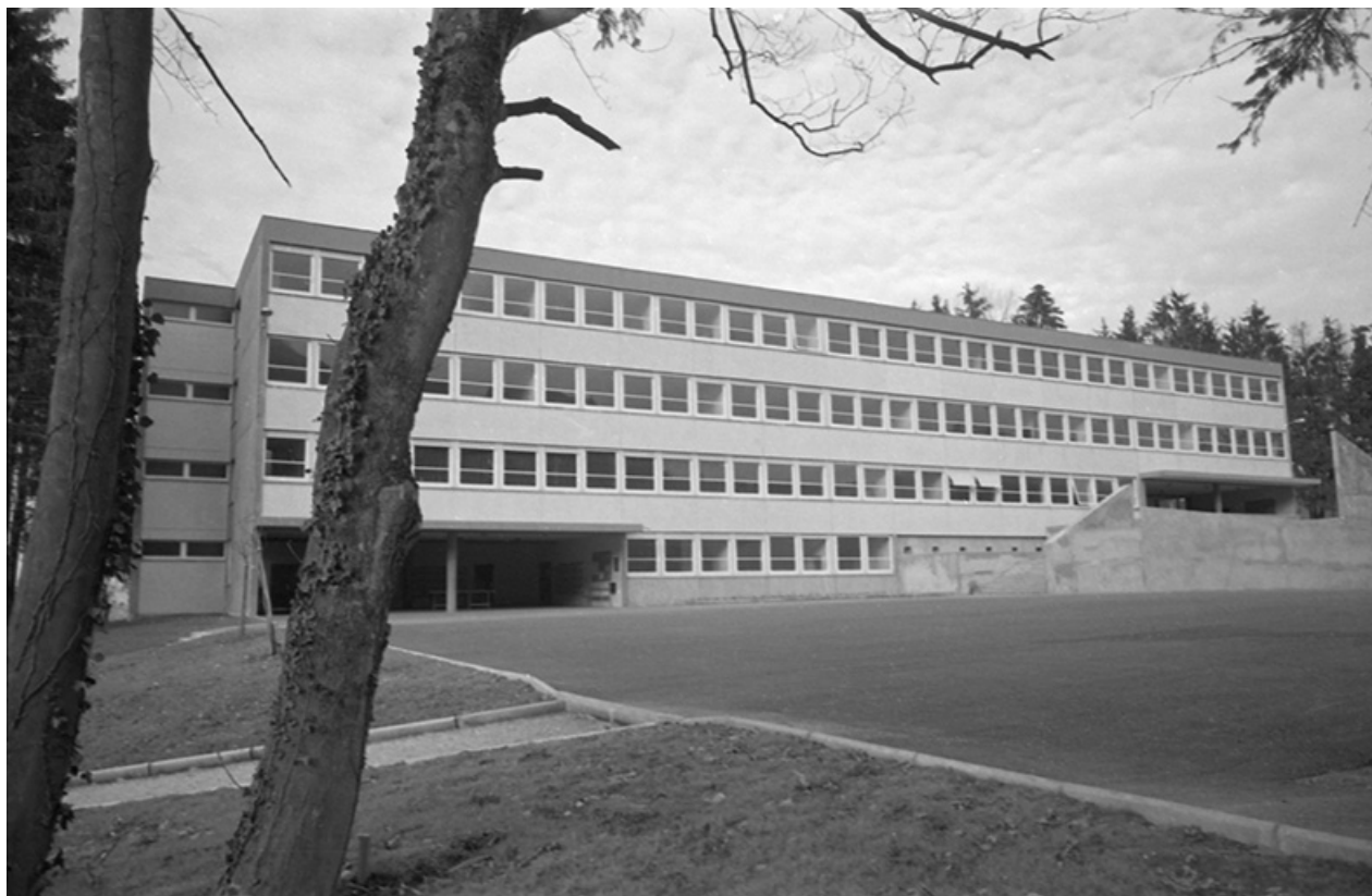
Façade antérieure de l'externat, s.d. [vers 1965].
