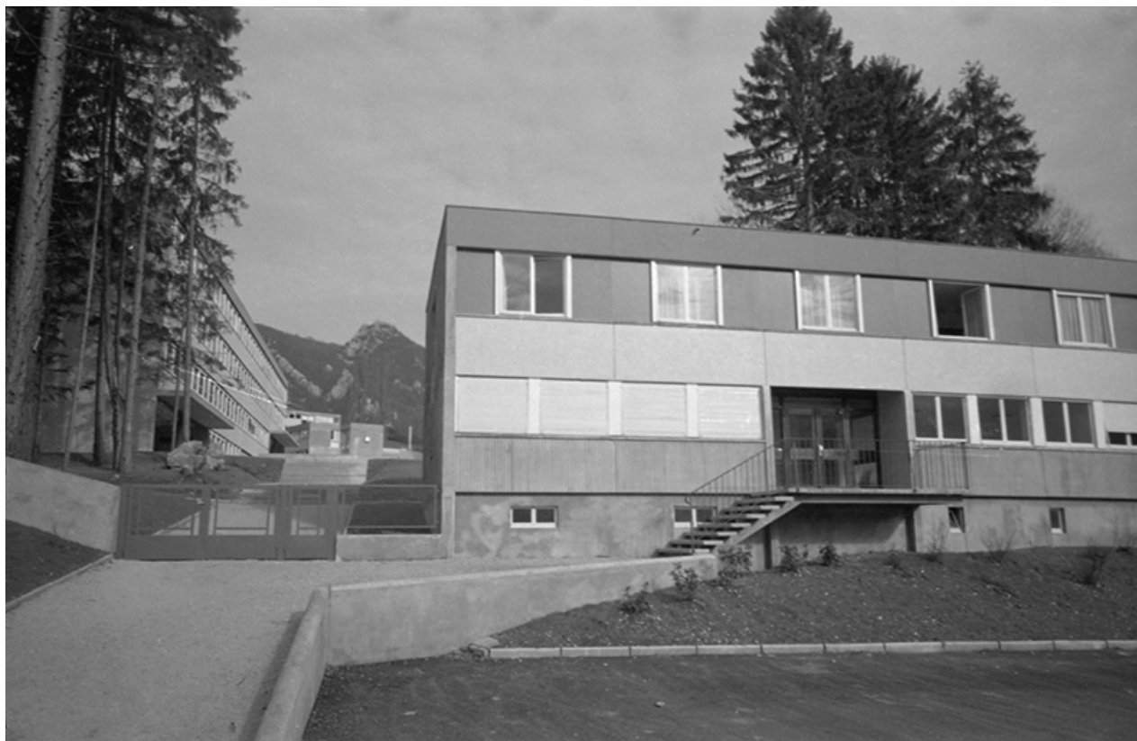
Entrée. A droite, le bâtiment administratif, s.d. [vers 1965].
