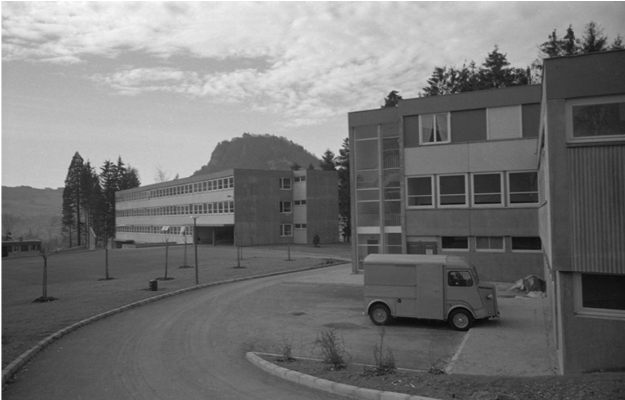
L'externat et le bâtiment de restauration, depuis le nord-est, s.d. [vers 1965].
