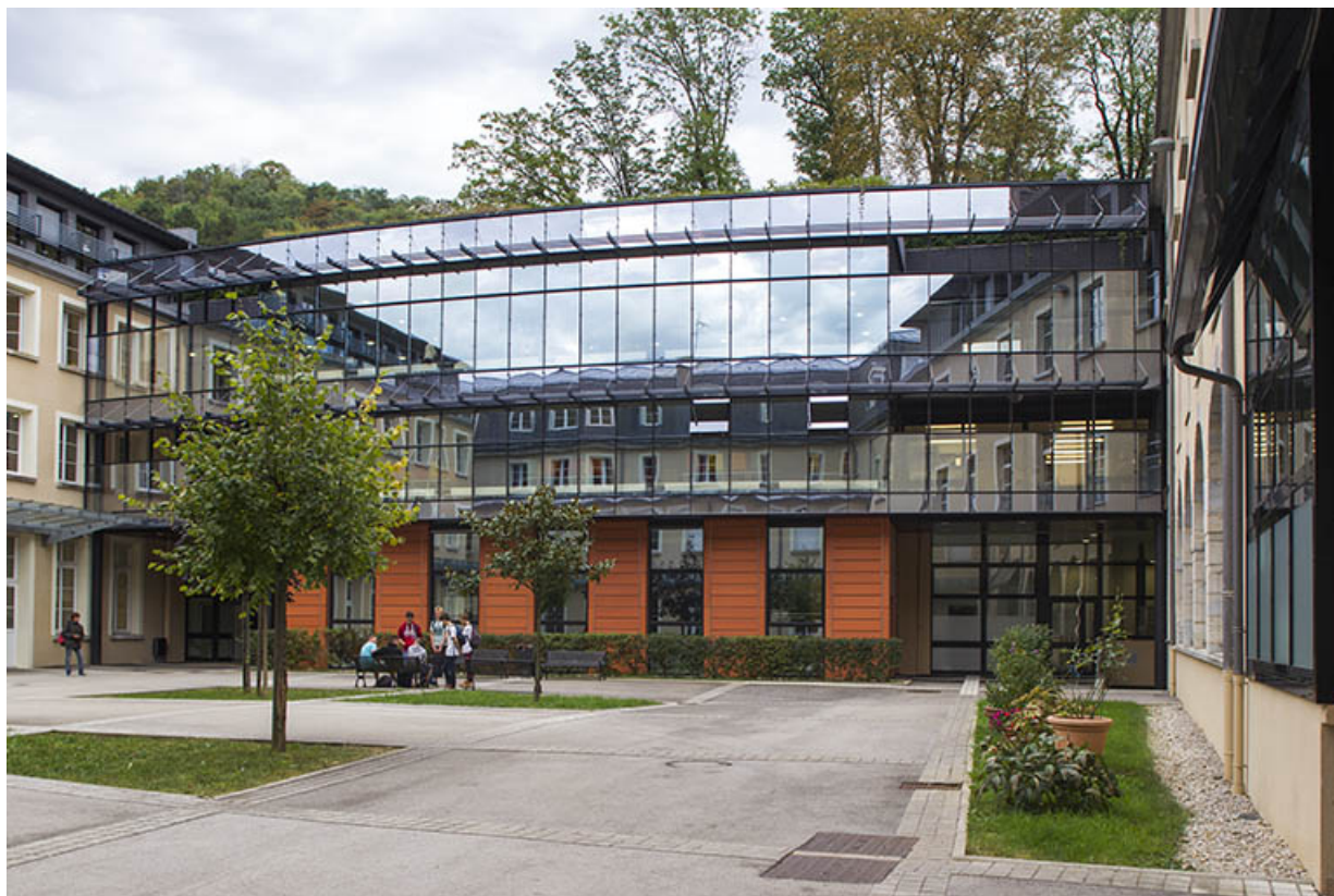
Aile Est : façade antérieure sur cour.
