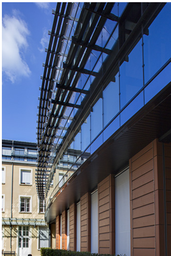
Aile Est : détail de la façade sur cour.
