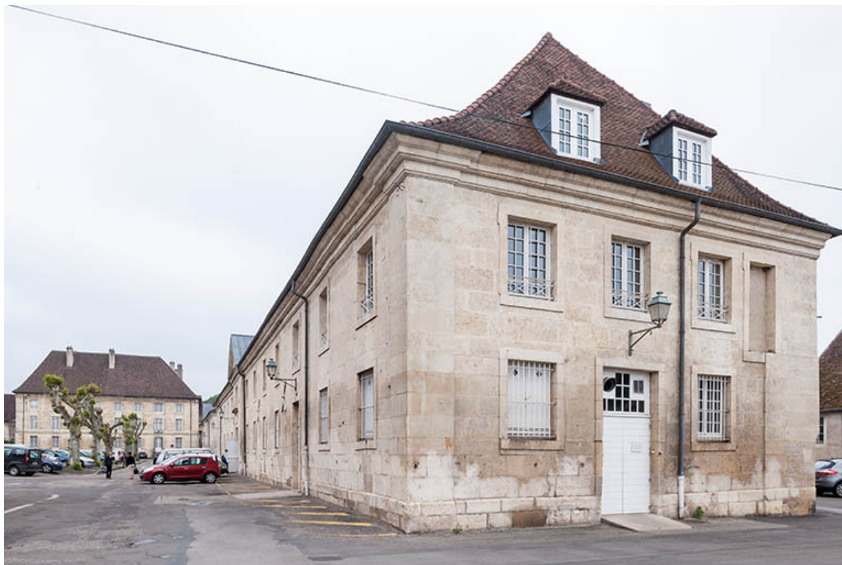
Bâtiment restauration-externat, pignon sud. 39, Dole, 31 place Barberousse
