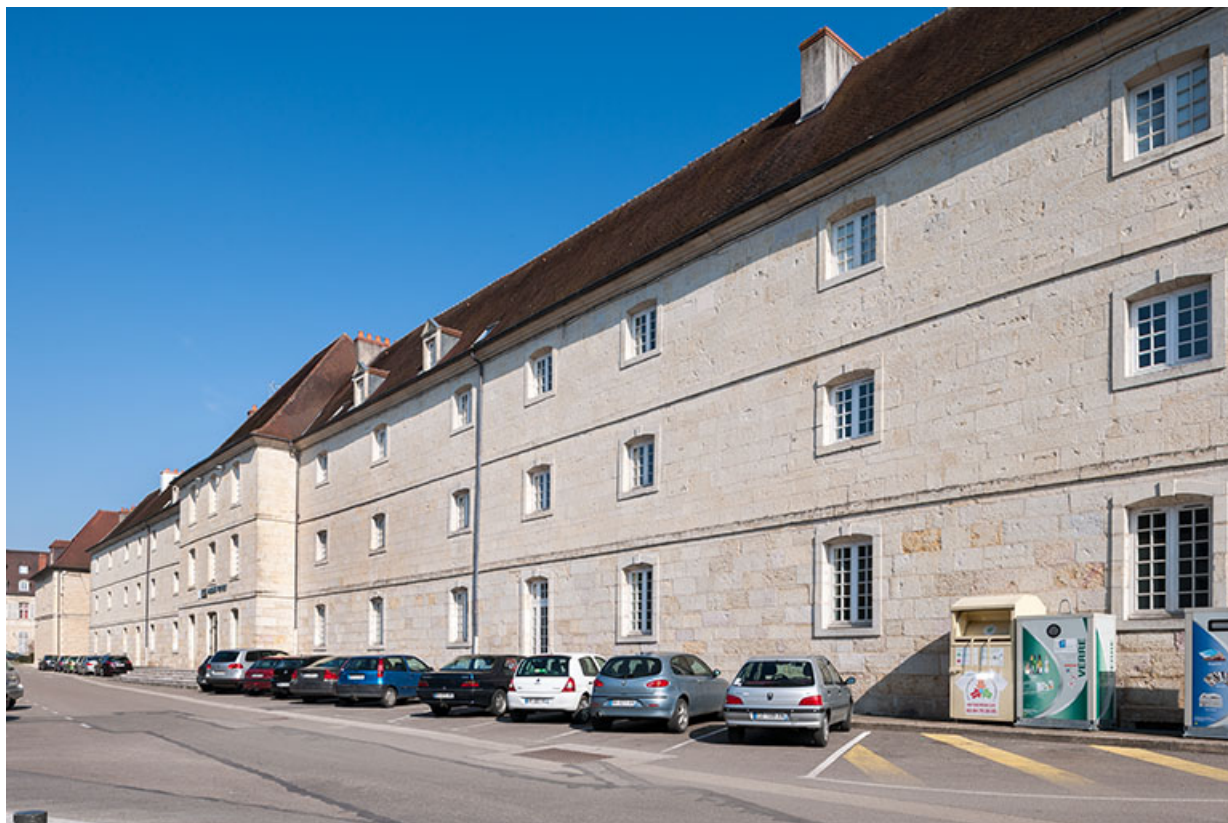
Externat : façade postérieure, place Barberousse.
