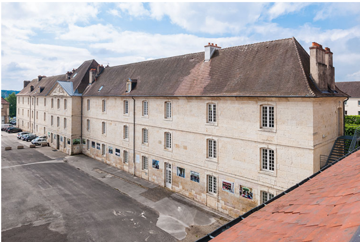
Externat : vue 3/4 depuis le nord de la façade antérieure.
