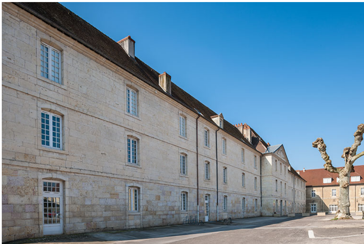
Externat : Vue 3/4 façade antérieure, place Précipiano.
