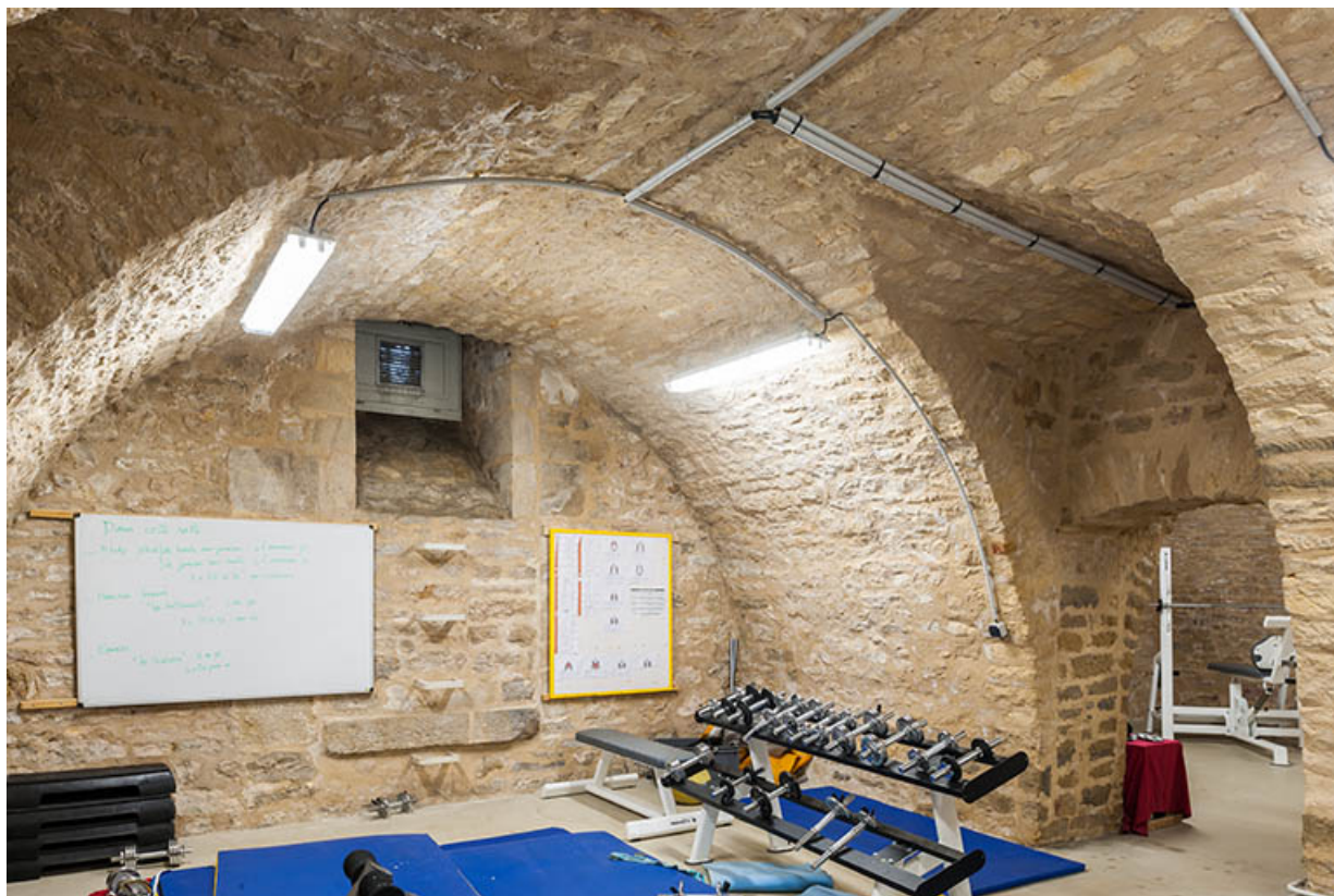
Externat : sous-sol voûté, salles de musculation.
