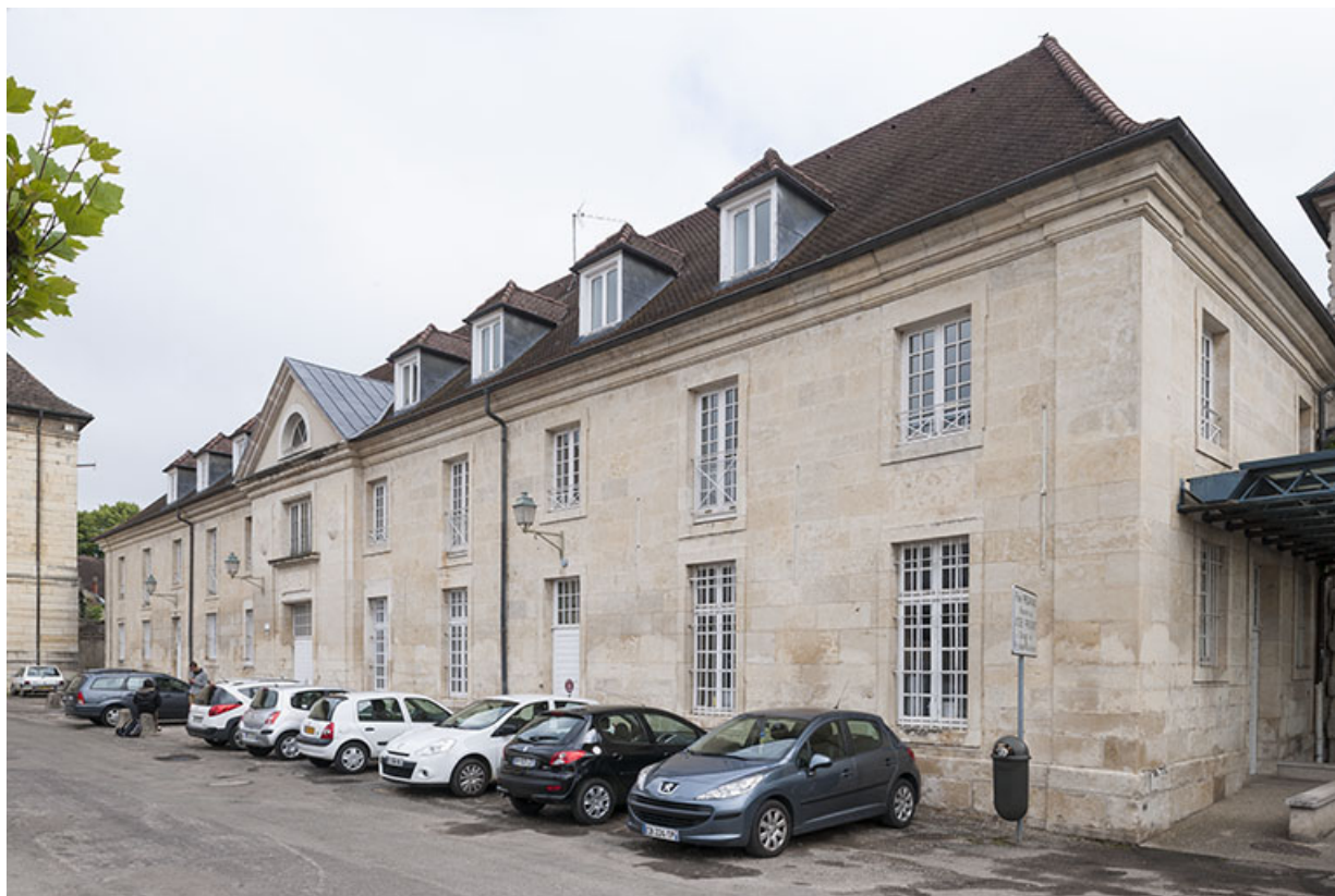
Bâtiment atelier-logement : vue 3/4 depuis le sud.
