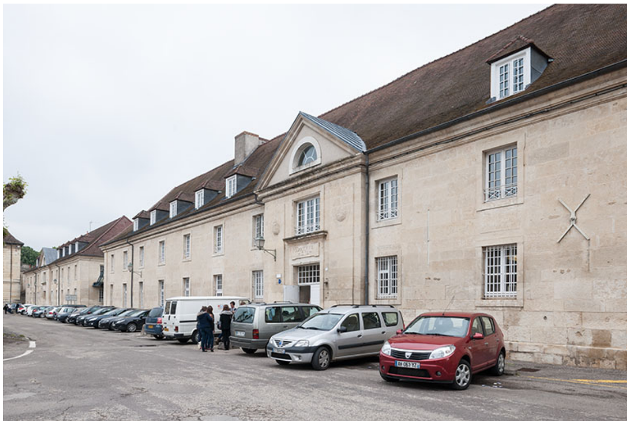
Bâtiment restauration-externat : façade postérieure.
