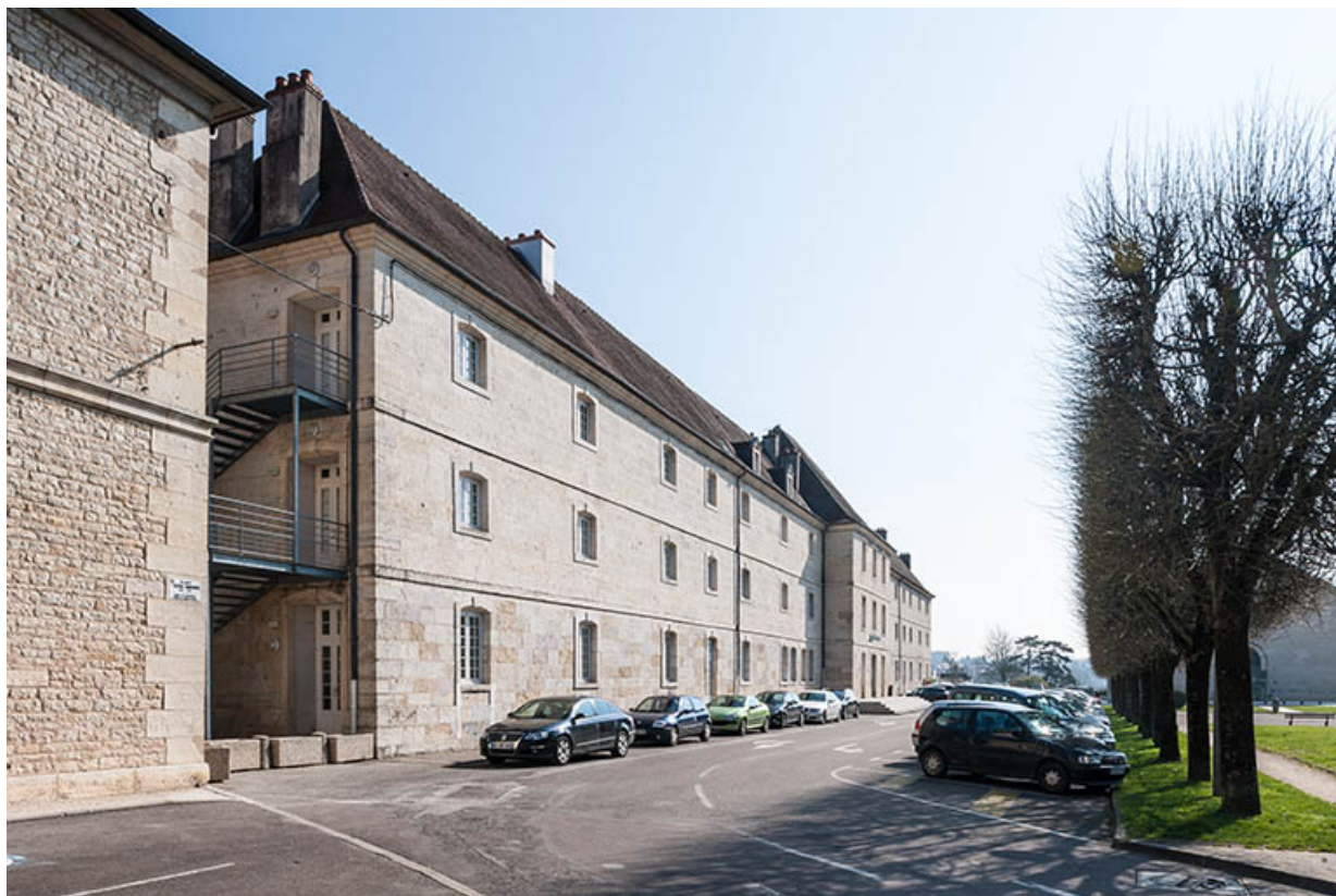
Externat : façade postérieure, place Barberousse, vue depuis la rue des Arènes. 39, Dole, 31 place Barberousse
