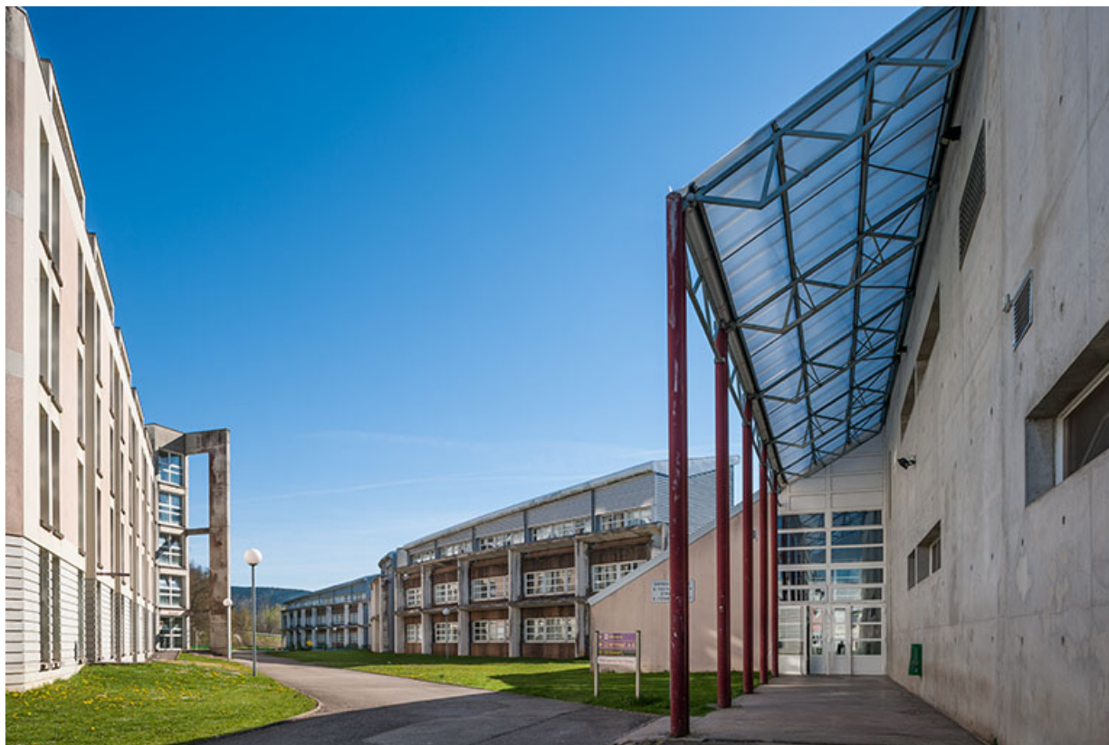
Les façades des bâtiments d'externat et d'internat depuis la rue intérieure.
