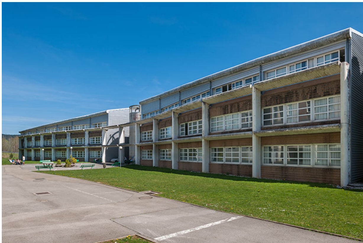
Externat : façades sur rue intérieure, partie Nord.
