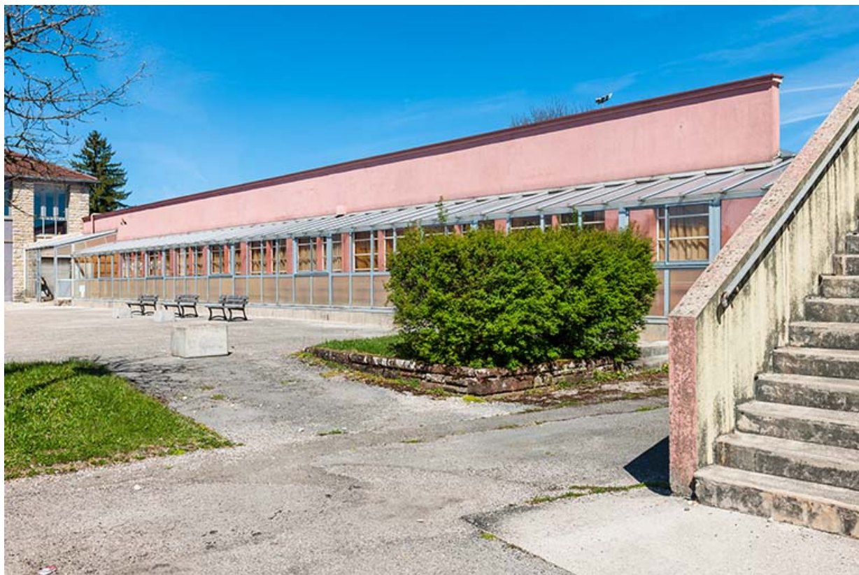
Atelier, site avenue Edouard Herriot : façade antérieure.
