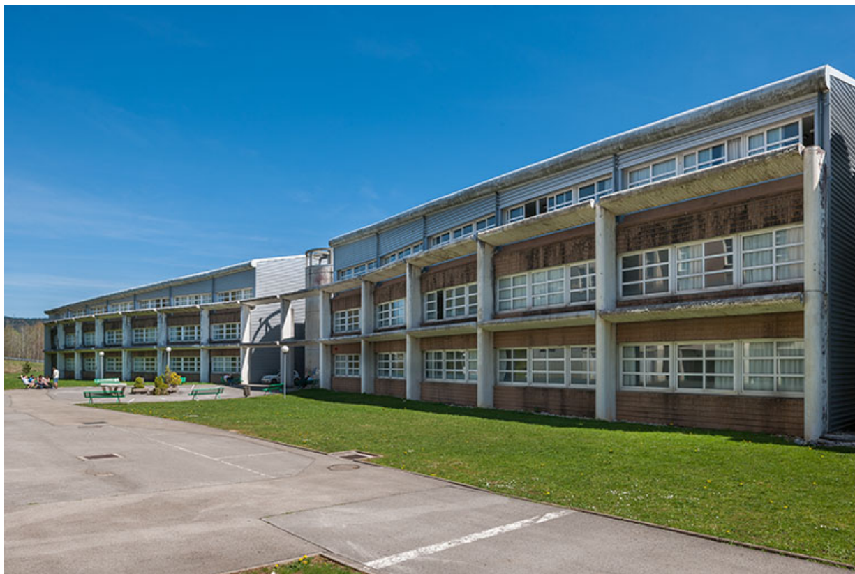
Externat : façades sur rue intérieure, partie Nord.
