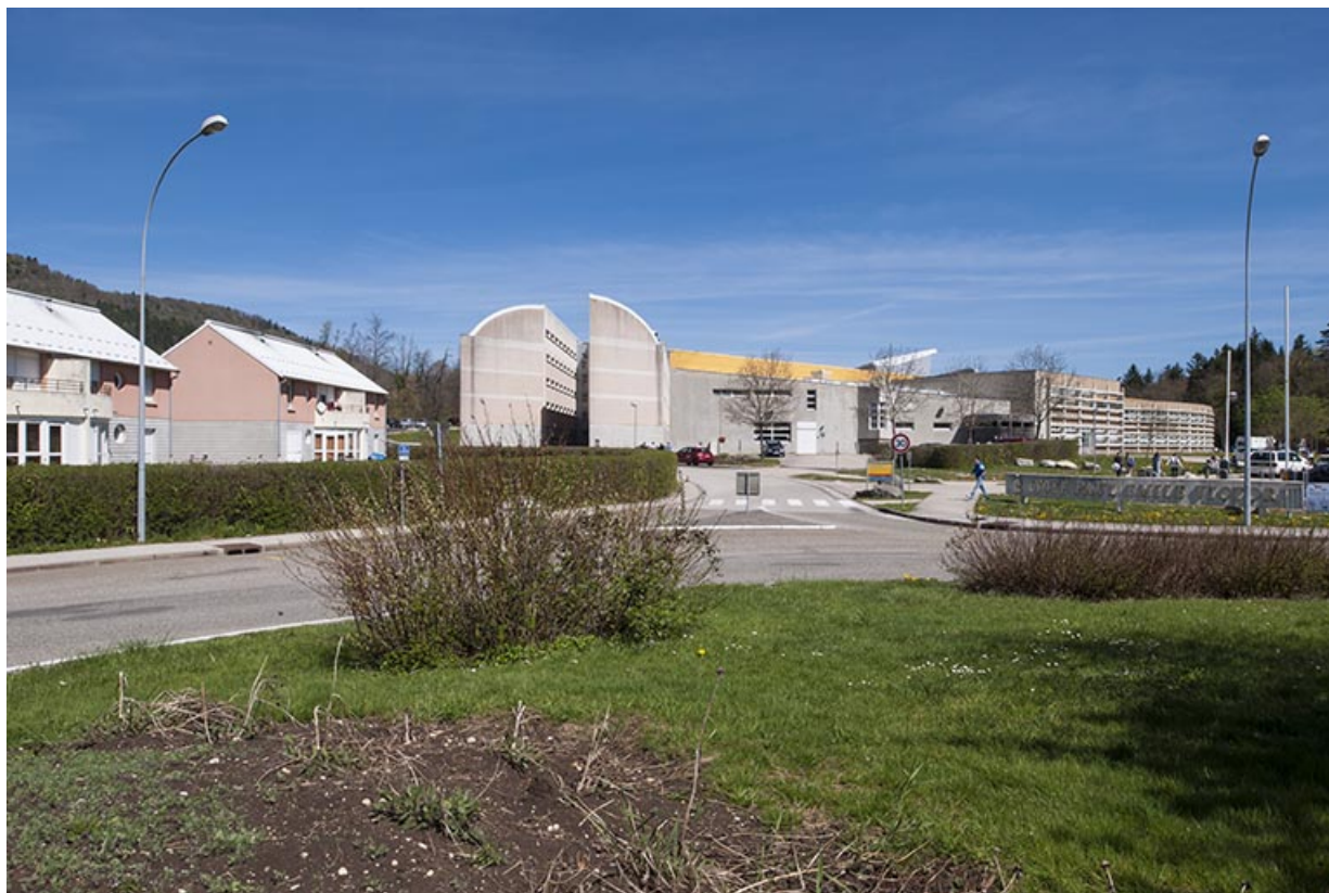
Site du lycée avec à gauche logements, au centre internat et au second plan, administration -restauration.
