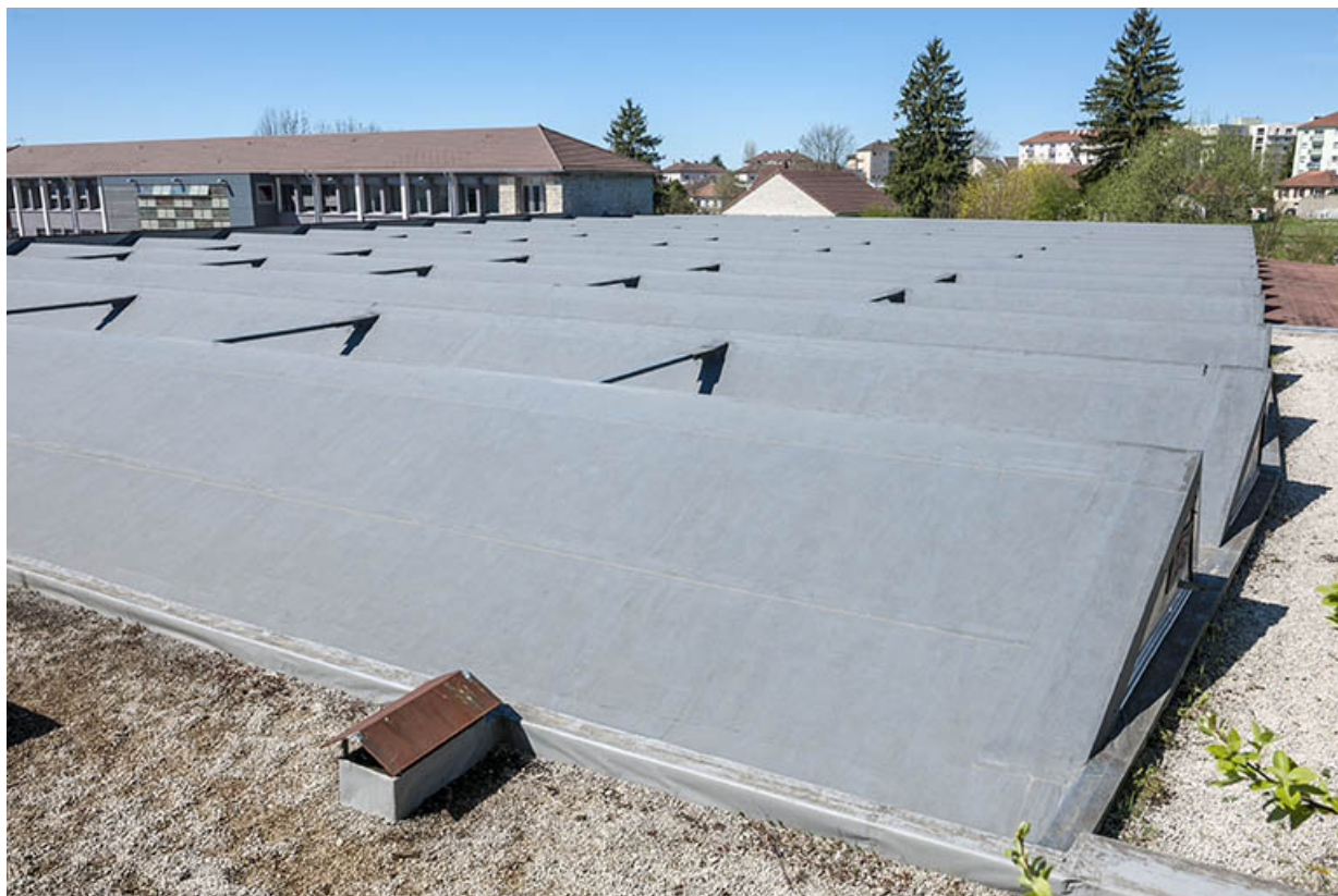
Atelier, site Edouard Herriot, toiture en sheds.
