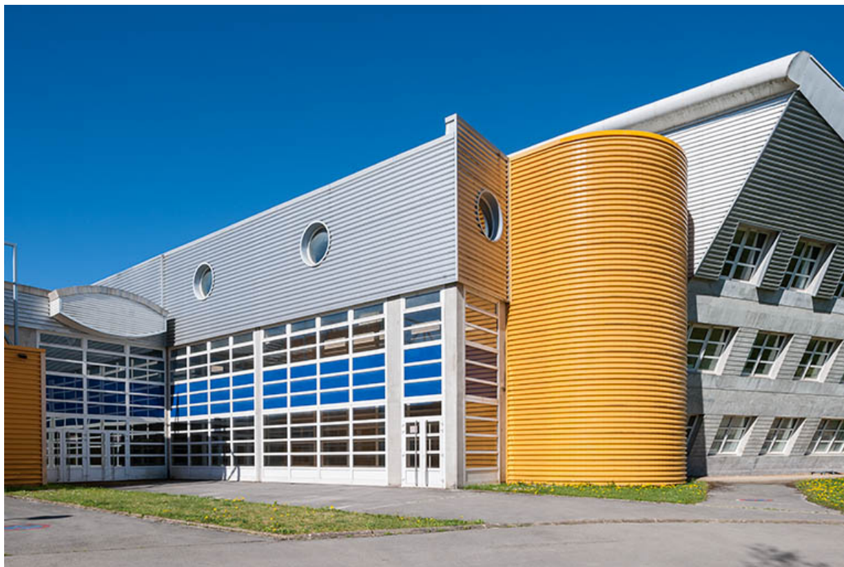
Externat : façade latérale Nord, détail.
