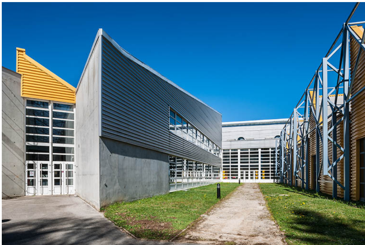
Façades Est, de gauche à droite : pignon de l'administration, façade du CDI, façade postérieure de l'externat et façades de l'atelier. 39, Champagnole, 625 avenue de Gottmadingen
