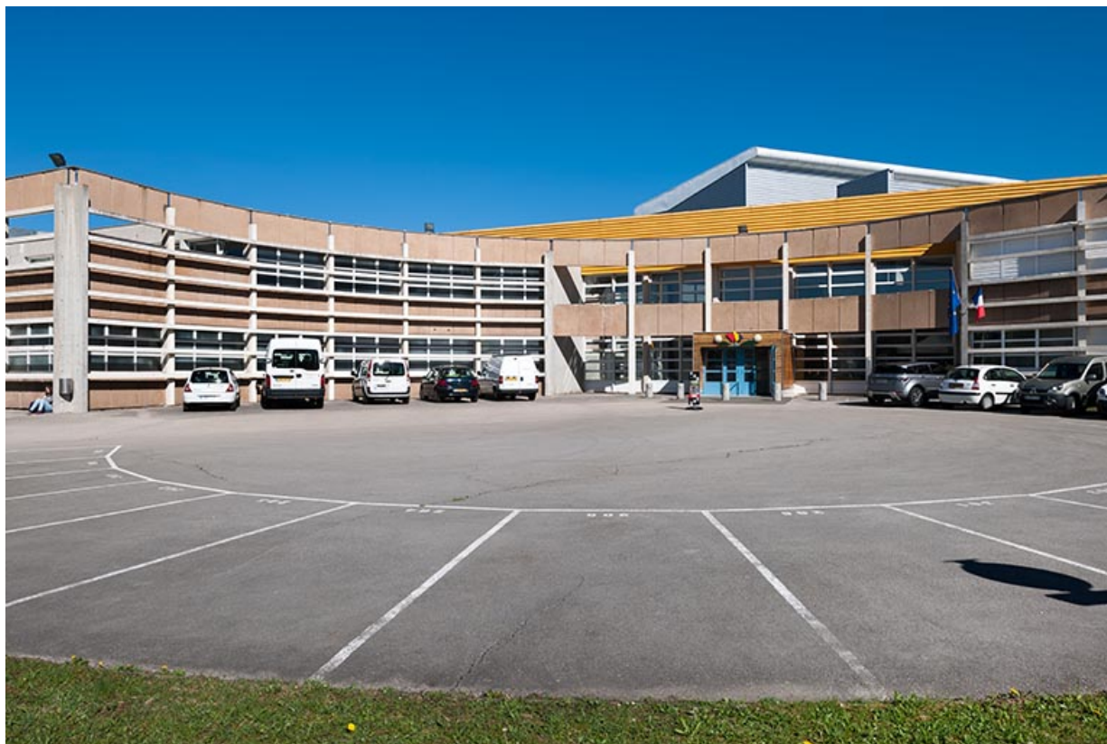
Administration-restauration : accès principal. 39, Champagnole, 625 avenue de Gottmadingen
