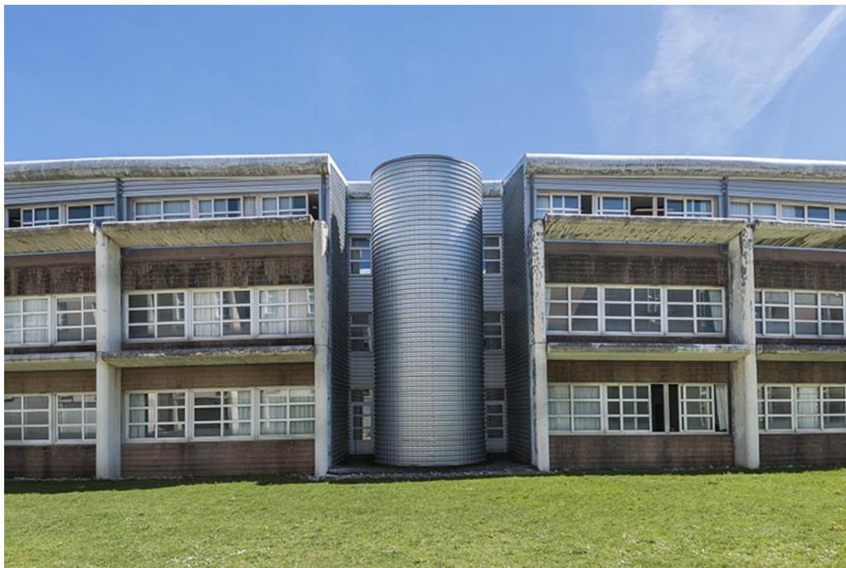
Externat : façades antérieures, partie Sud, partagée par la cage d'escalier.
