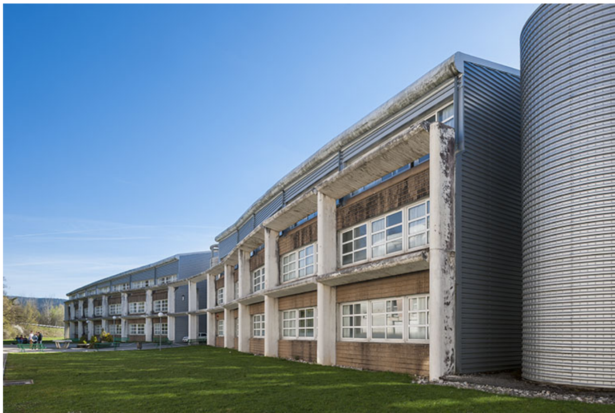
Externat : façades antérieures, voie intérieure entre internat et externat.
