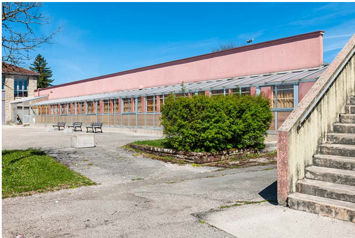
Atelier, site avenue Edouard Herriot : façade antérieure.
