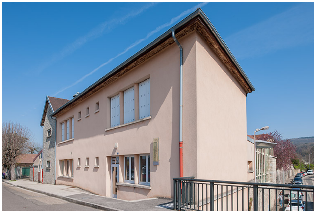
Annexe : façade antérieure, rue des écoles. 39, Arbois, 1 rue des Ecoles
