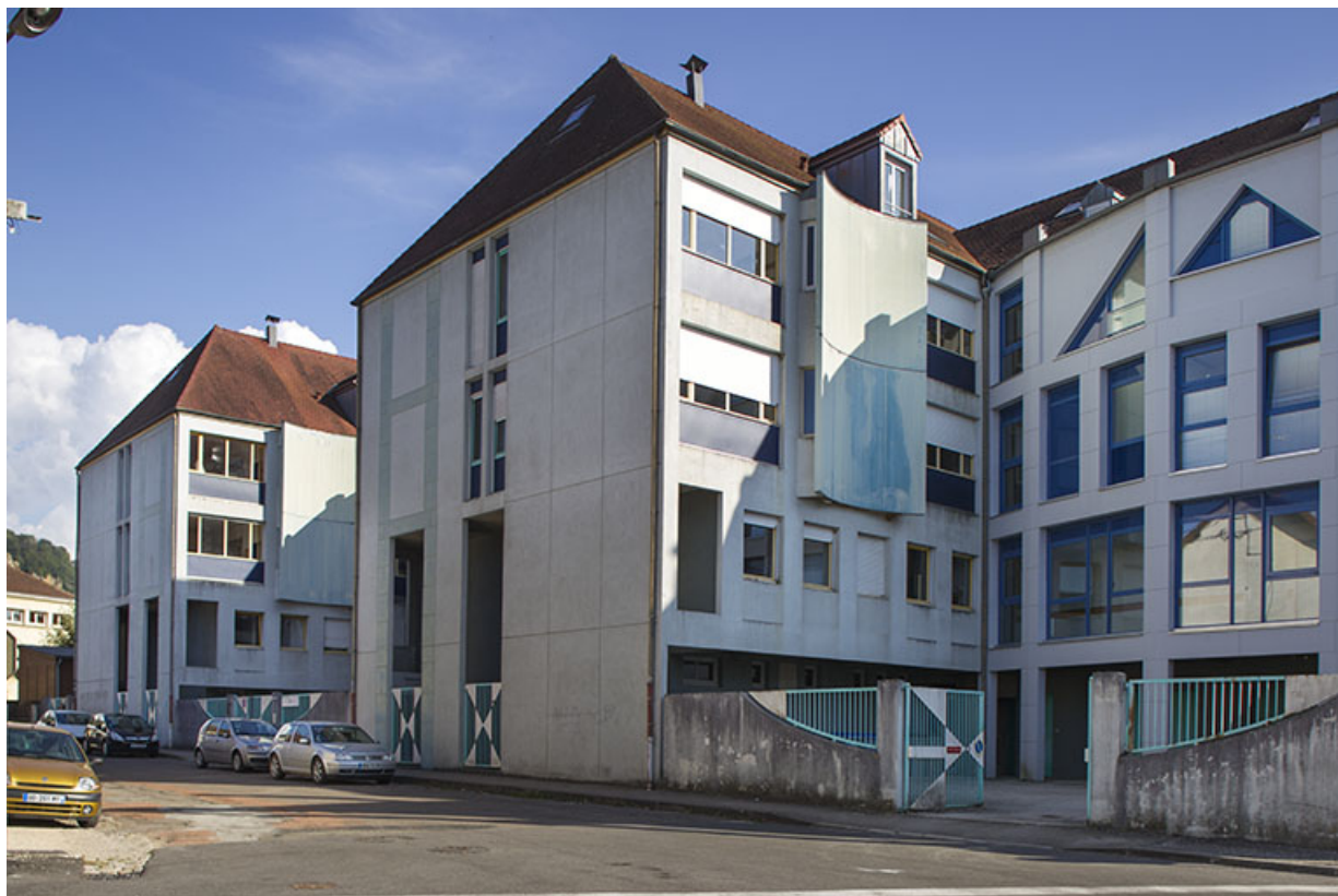
Internat : façades Nord sur la rue de la Résistance.
