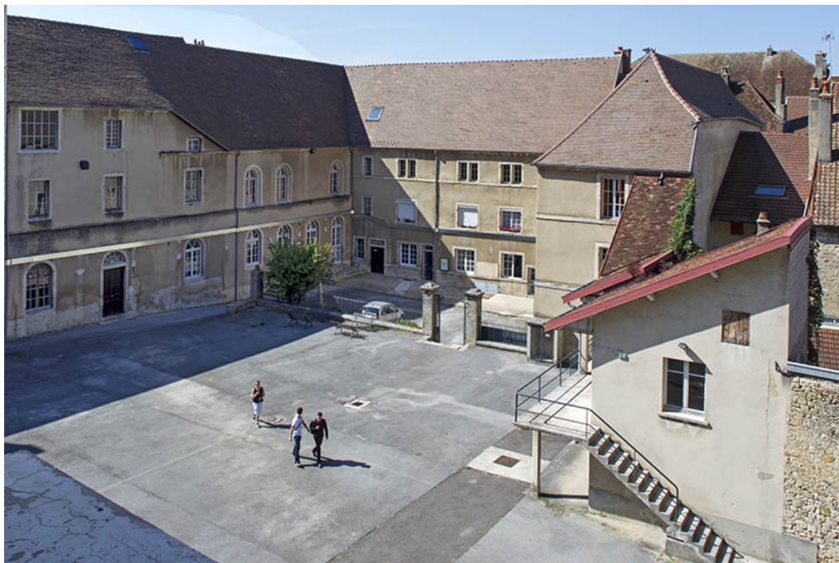
Externat : vue de la cour des oratoriens avec les adjonctions récentes.
