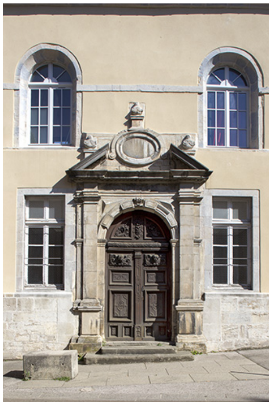
Site des oratoriens : façade Ouest sur la rue du collège, porte dite des anges. 39, Poligny, 42 rue du Collège
