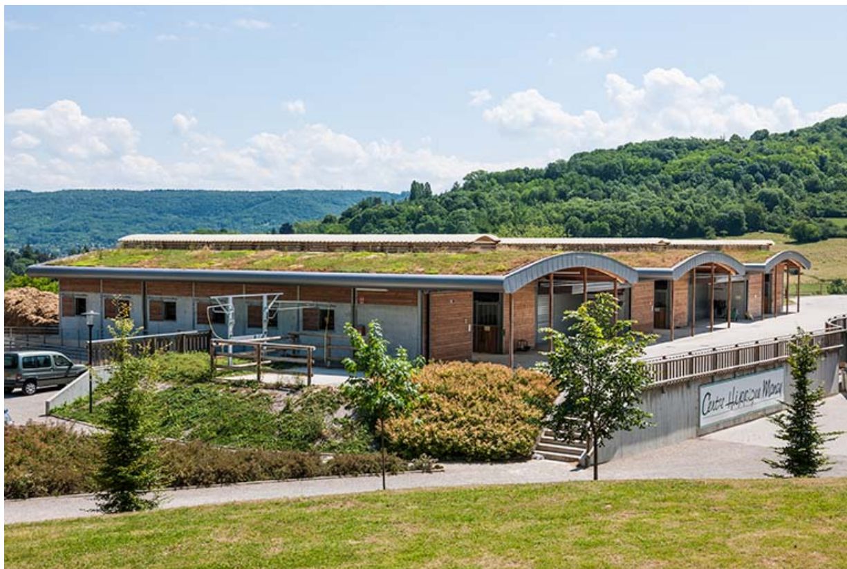
Centre équestre : vue générale des boxes d'enseignement.
