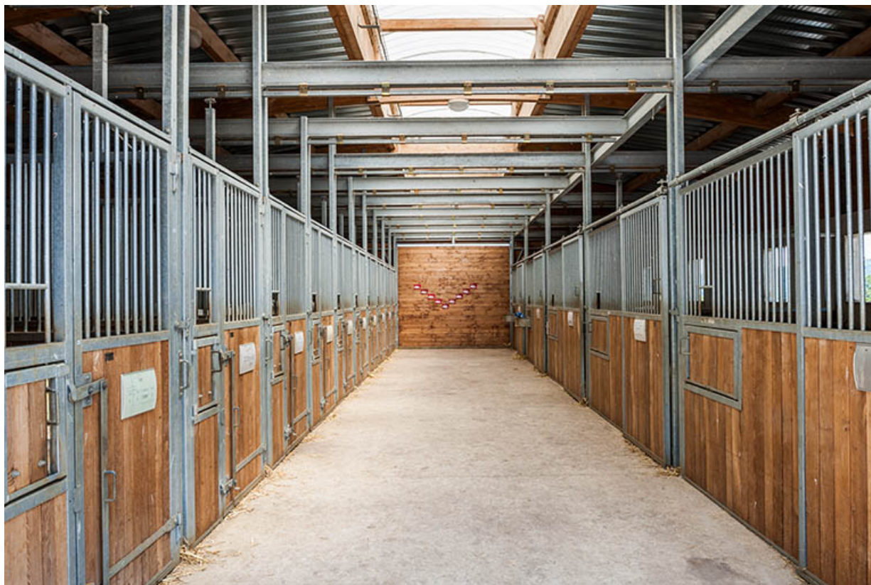
Centre équestre : boîtes d'enseignement, allée centrale.
