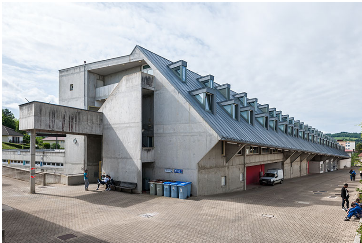
Façades et pignon nord du bâtiment internat-administration.
