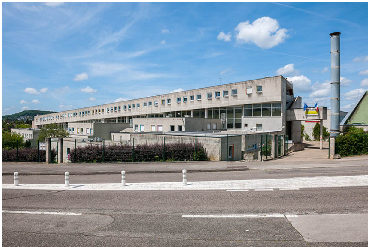
Vue générale depuis la rue Charles Ramey 39, Lons-le-Saunier, rue 255 Charles Ramey
