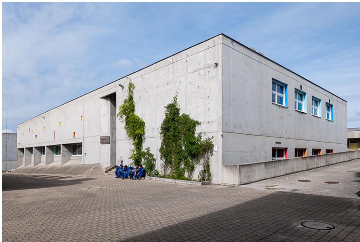
Atelier métal : façade sur rue intérieur et pignon nord.
