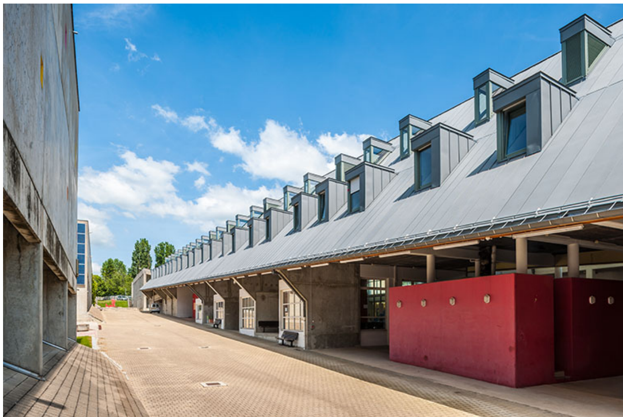
Façade sur rue intérieure du bâtiment internat - administration : toiture métallique avec chien-assis 39, Lons-le-Saunier, rue 255 Charles Ragmey
