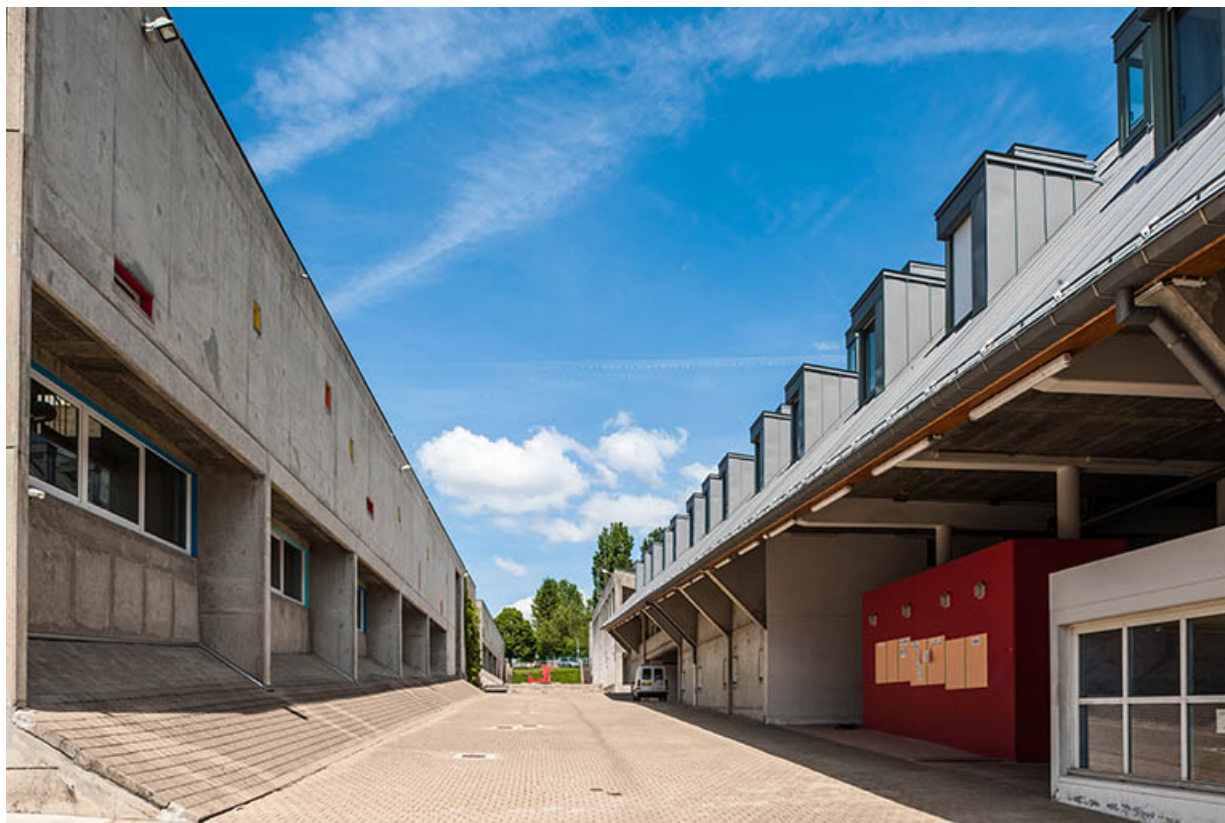
Vue de la rue séparant ateliers et internat-administration depuis le sud.
