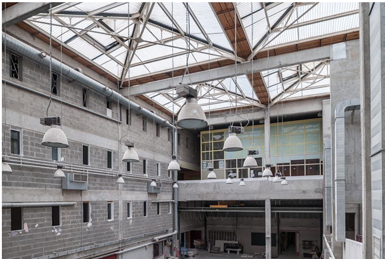
Atelier béton : intérieur, charpente et toiture. 39, Lons-le-Saunier, rue 255 Charles Ragmey
