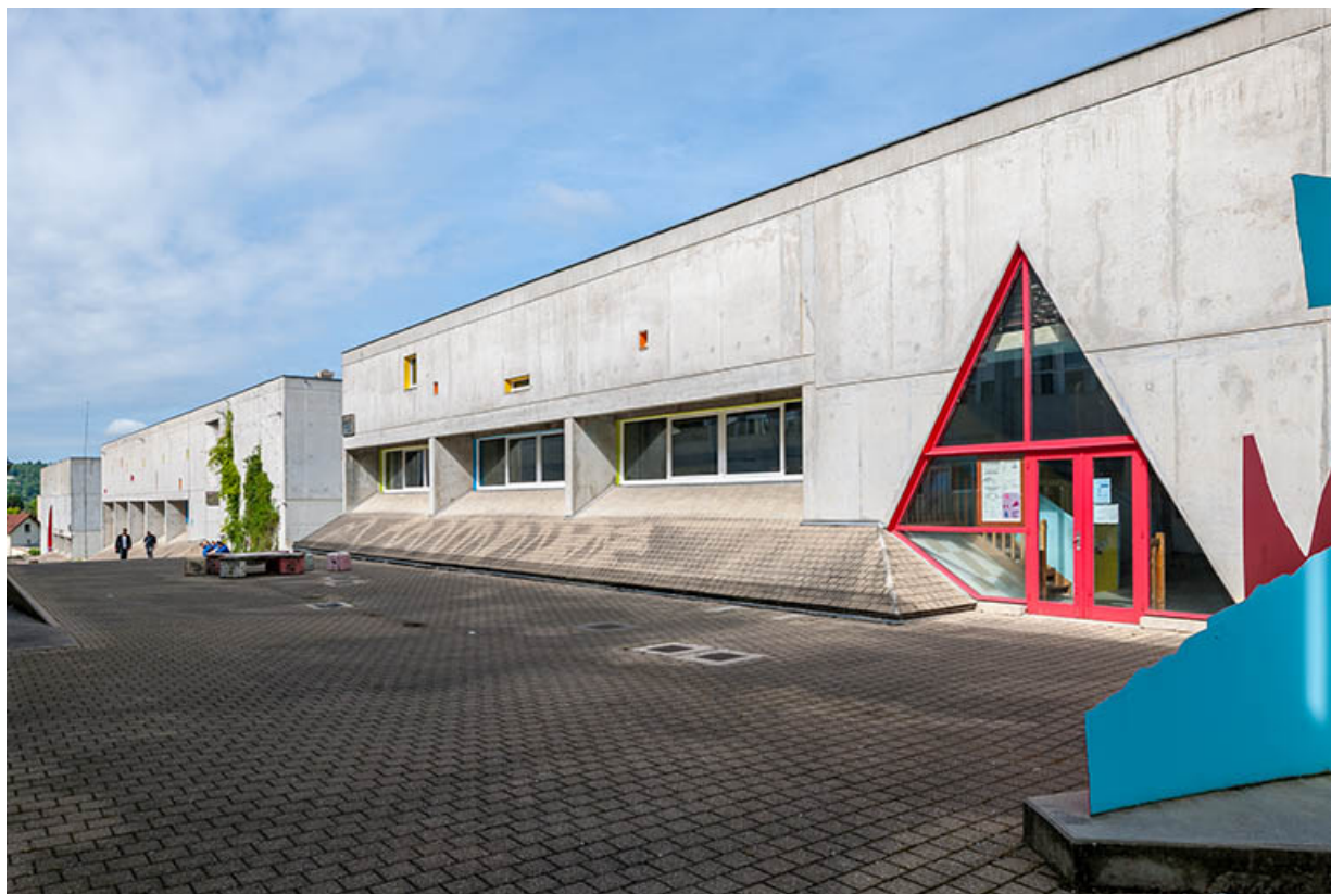
Atelier bois : façade antérieure sur rue intérieure.
