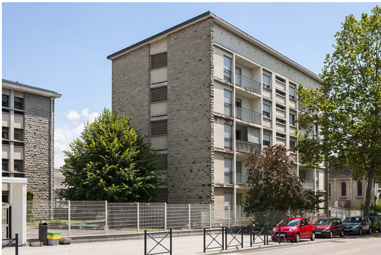
Bâtiment administration-logements, vue de trois quart depuis la rue Michel sur façade antérieure. 39, Lons-le-Saunier, 400 rue du Docteur Jean Michel
