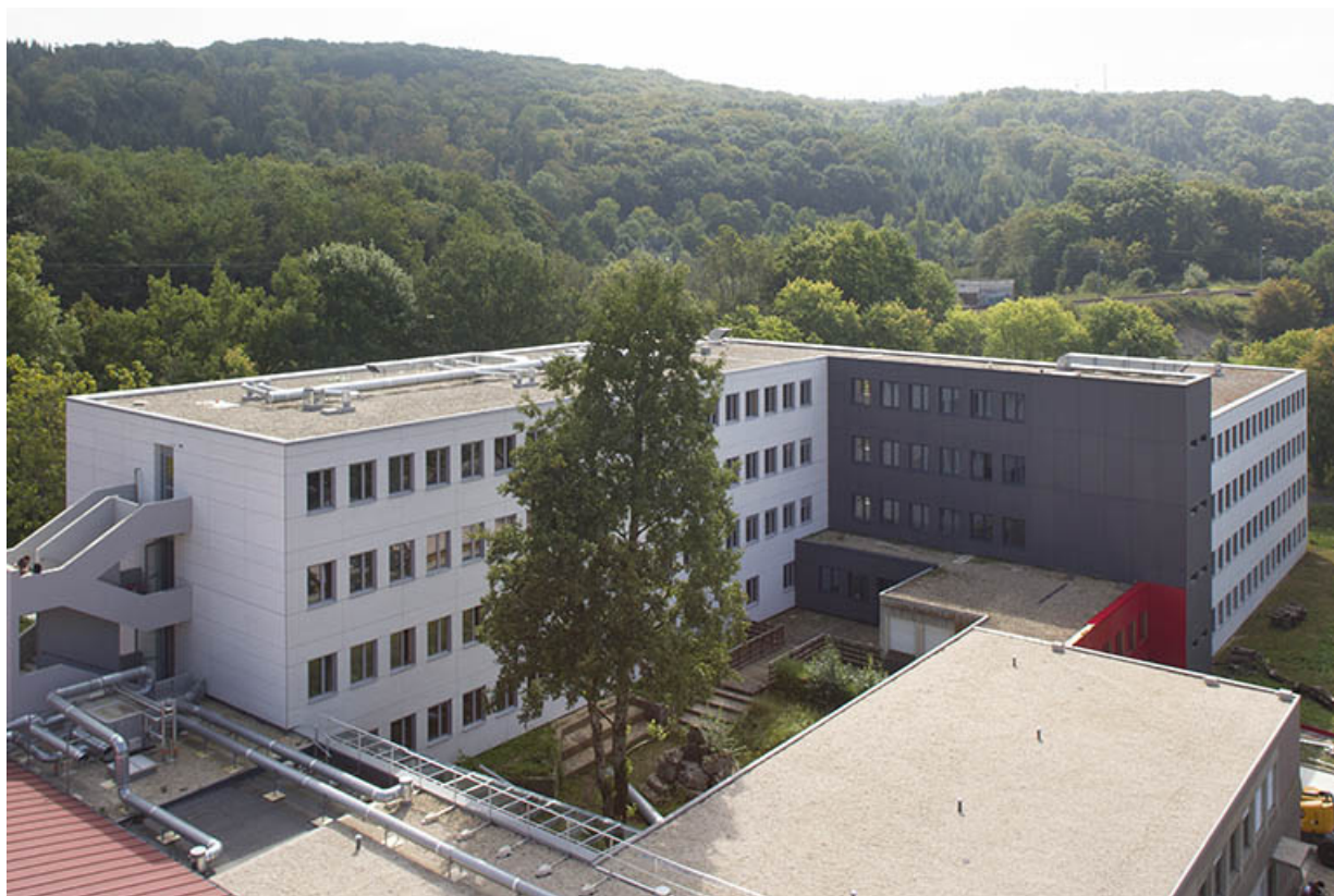
Internat : vue générale après restauration des façades.
