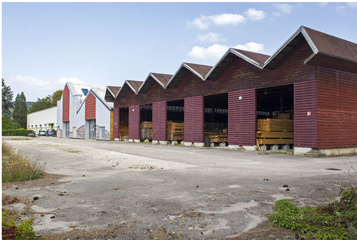
Bâtiment de stockage du bois et atelier : façades postérieures.
