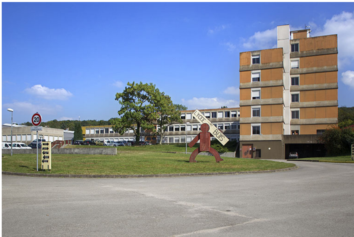
Vue générale avec au premier plan, le bâtiment de l'administration. 39, Mouchard, 67 rue de Strasbourg
