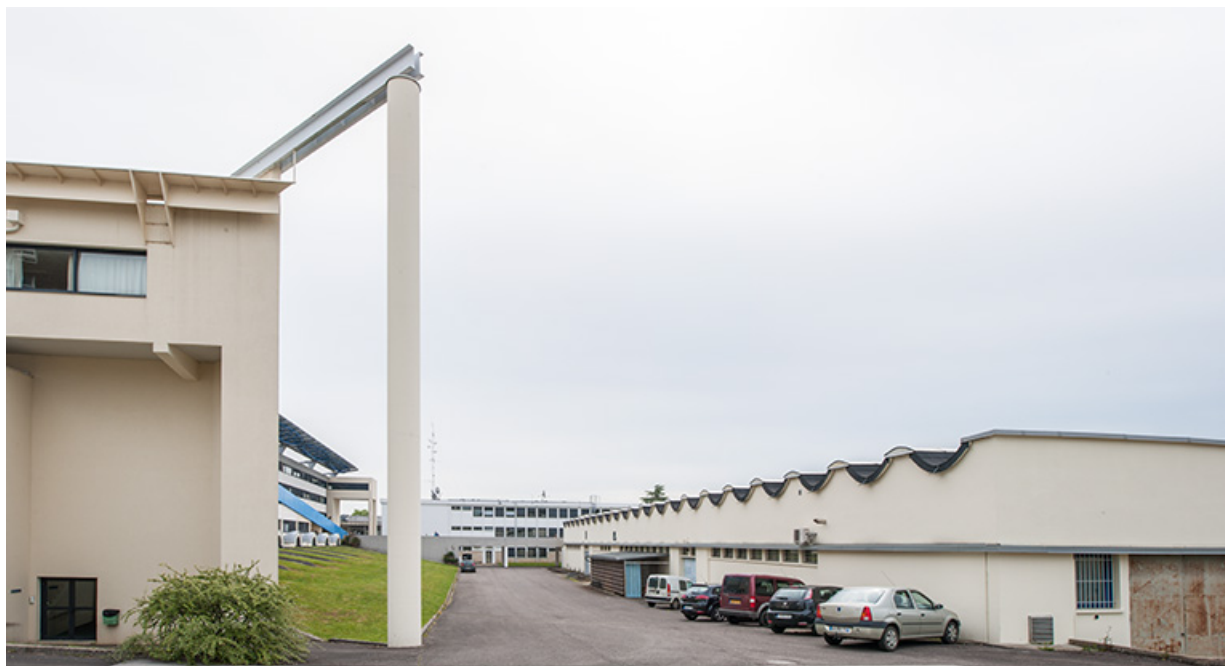
Ateliers : façade antérieure.
