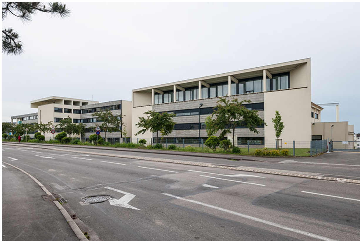
Vue générale des bâtiments d'externat depuis la rue Charles-Laurent Thouverey. 39, Dole rue Charles Laurent-Thouverey
