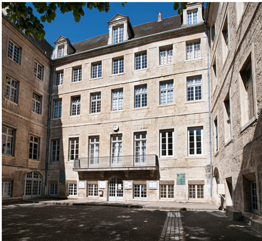
Façades de l'externat sur la cour intérieure.
