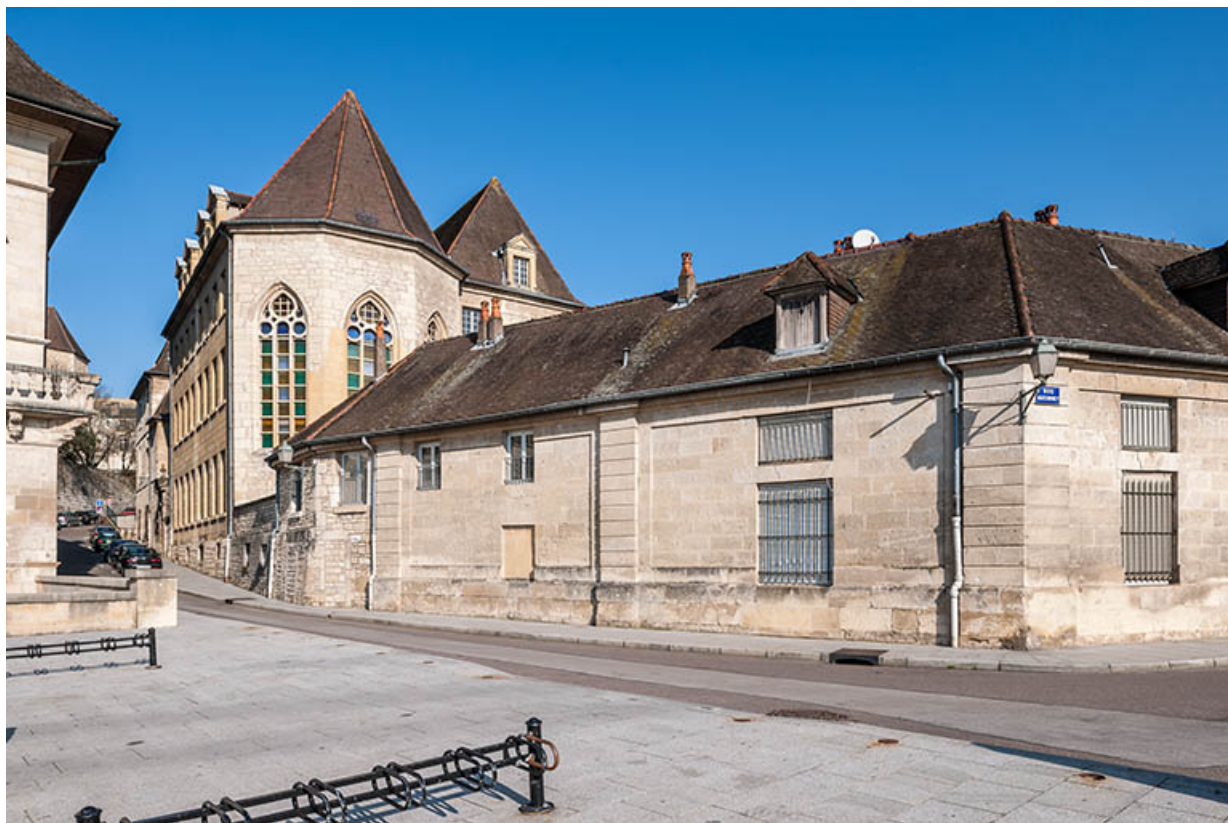
Façades des bâtiments logements, rue Bauzonnet, en arrière-plan la chapelle. 39, Dole, 6 Grande Rue
