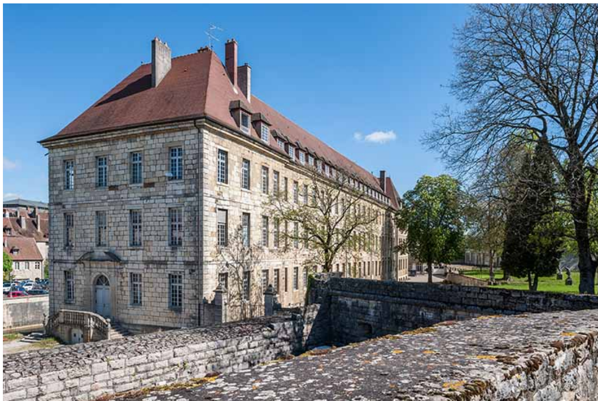
Ancien hôpital de la Charité, actuellement internat, vue façade postérieure et pignon ouest, remparts. 39, Dole, 6 Grande Rue
