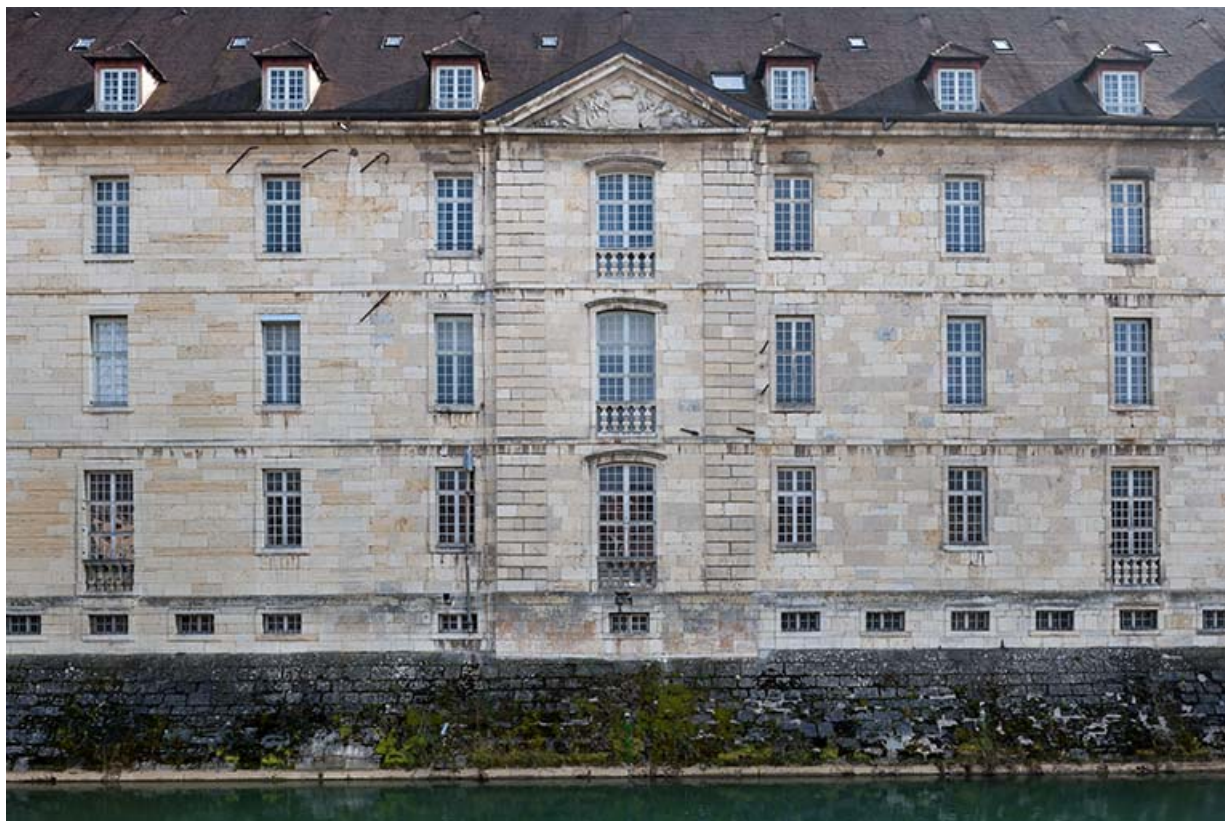
Ancien Hôpital de la Charité , vue de la façade antérieure sur le canal des Tanneurs.
