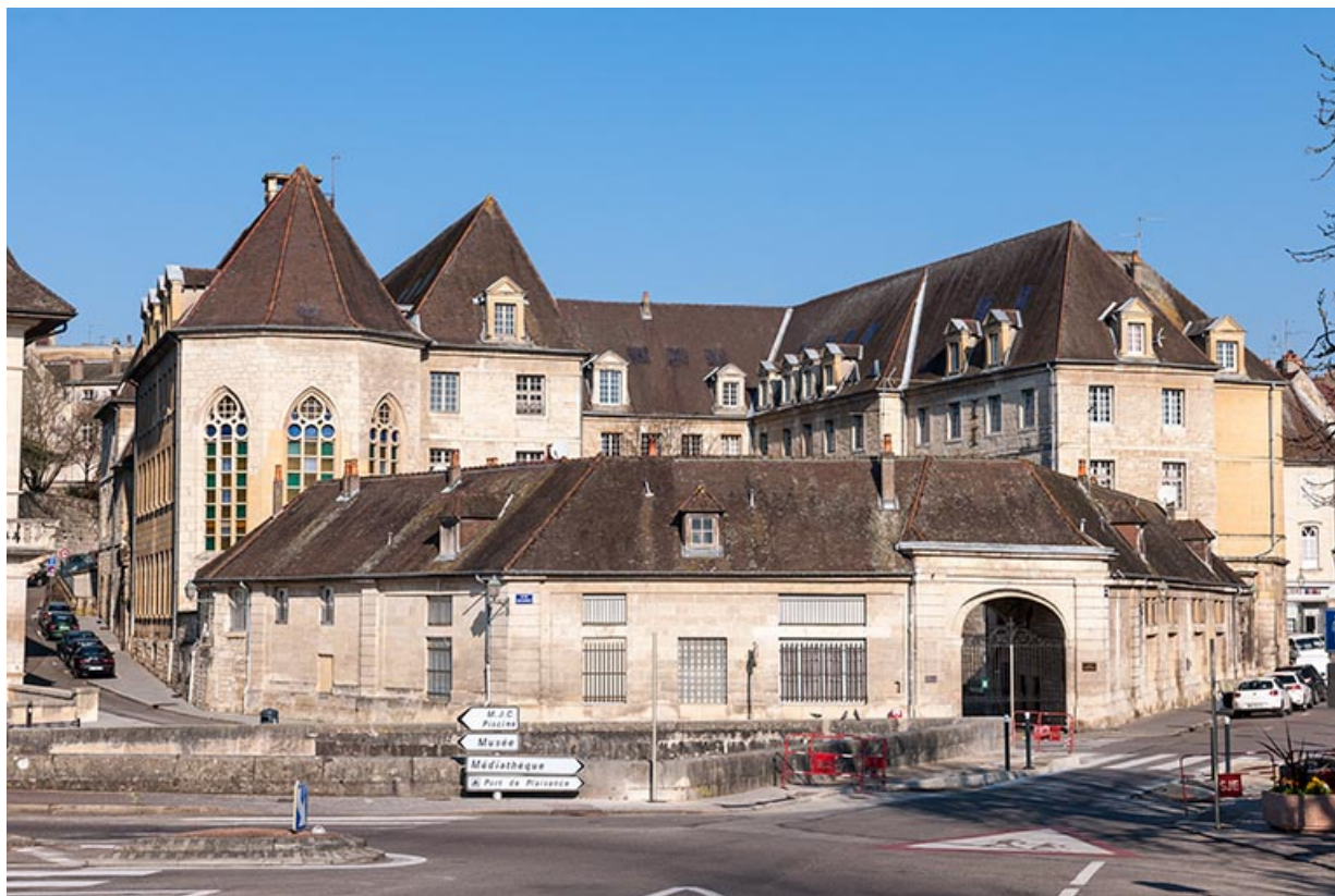
Vue générale du site occupé autrefois par le couvent des Dames d'Ounans.
