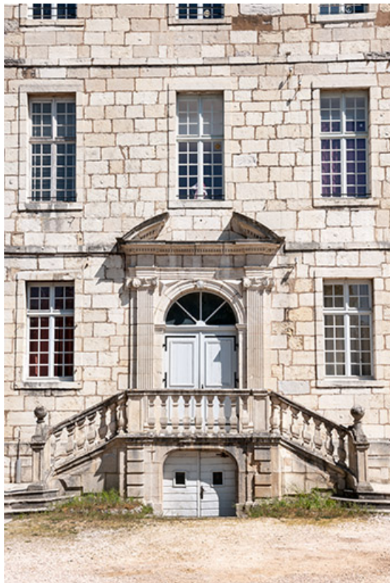
Ancien hôpital de la Charité, actuellement internat, portail d'entrée ouest. 39, Dole, 6 Grande Rue
