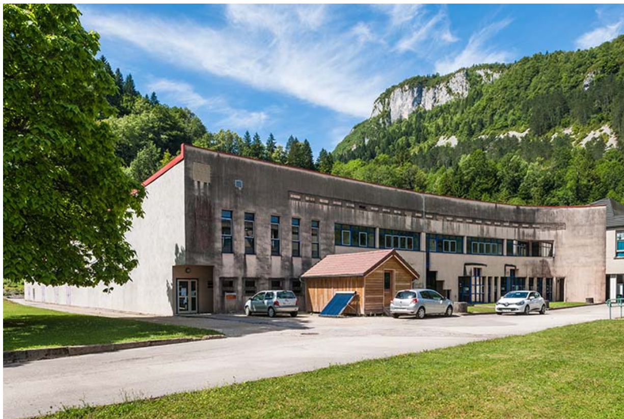
Atelier, ancien atelier mécanique : vue d'ensemble.
