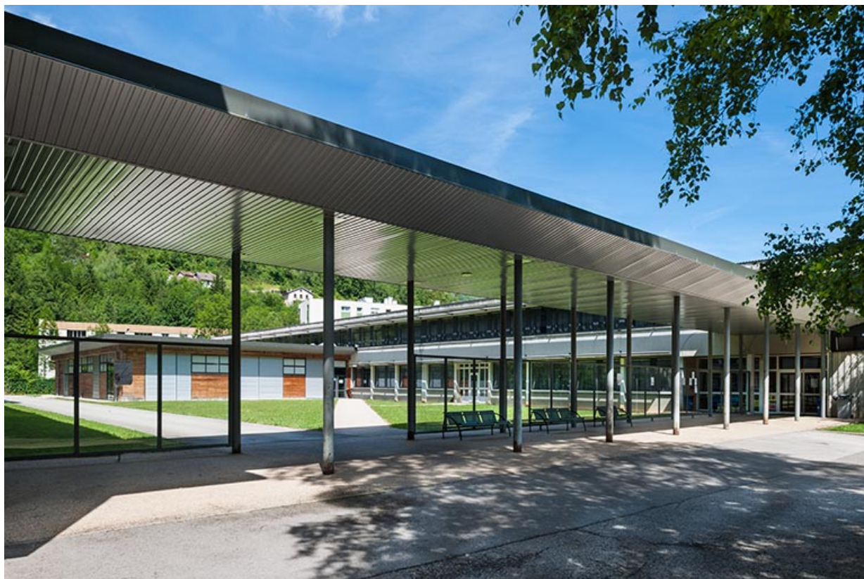
Passage couvert reliant l'atelier à l'externat tertiaire.
