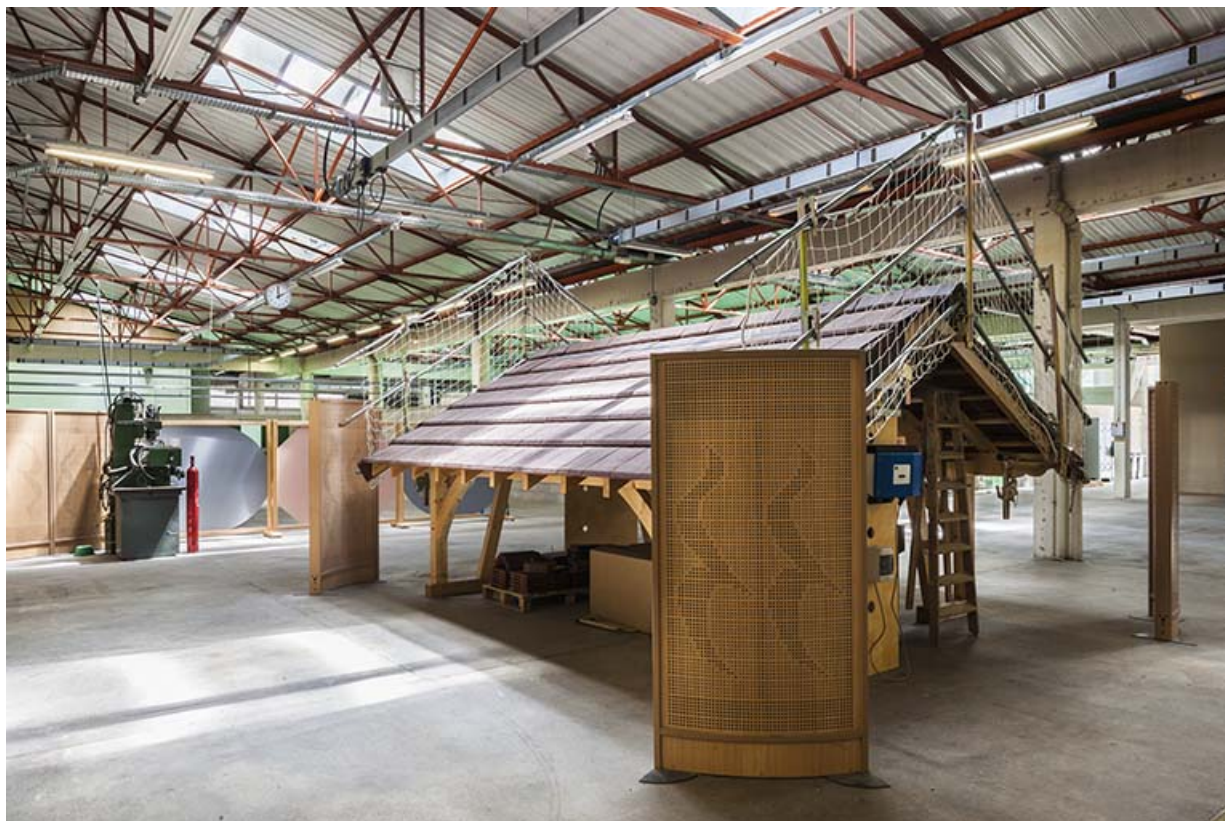
Atelier, ancien atelier mécanique, destiné aux formations sciences et technologies, énergie et environnement : intérieur. 39, Saint-Claude rue du Tomachon
