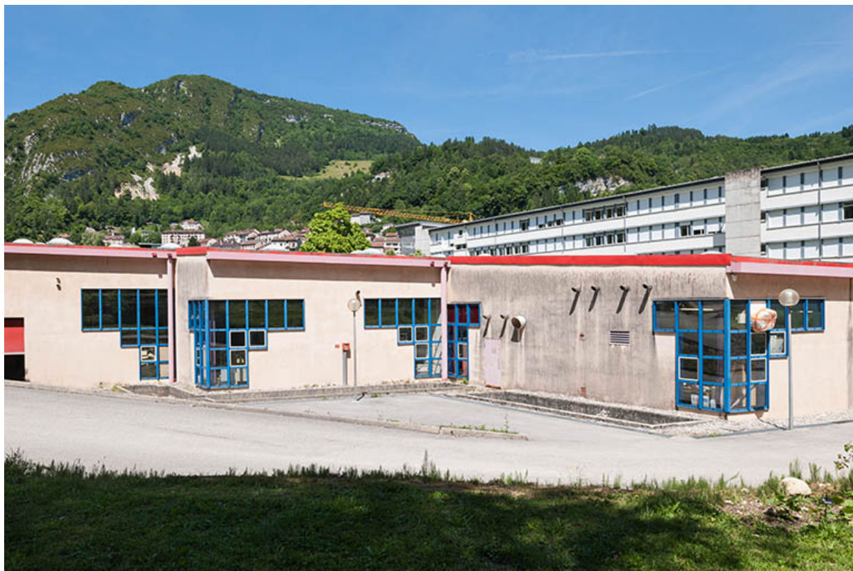
Atelier, ancien atelier mécanique : façade latérale Sud.
