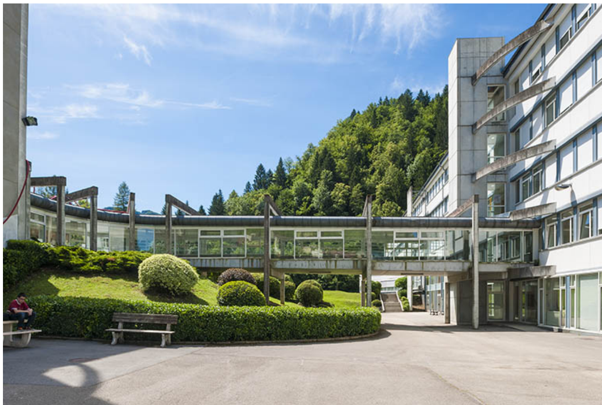
Passerelle couverte entre internat et externat . 39, Saint-Claude rue du Tomachon
