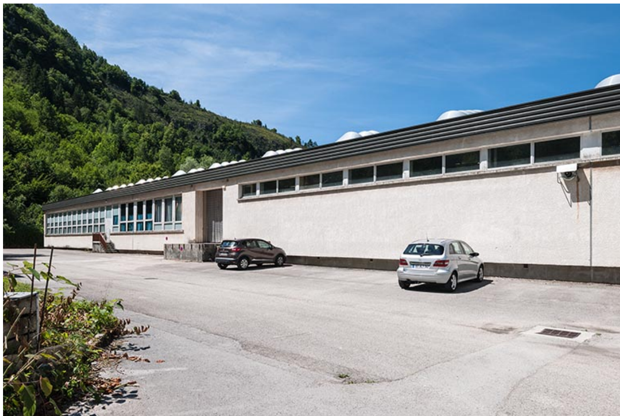
Atelier : façade postérieure.
