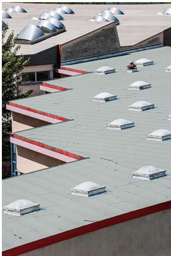
Toitures des deux ateliers : détail.
