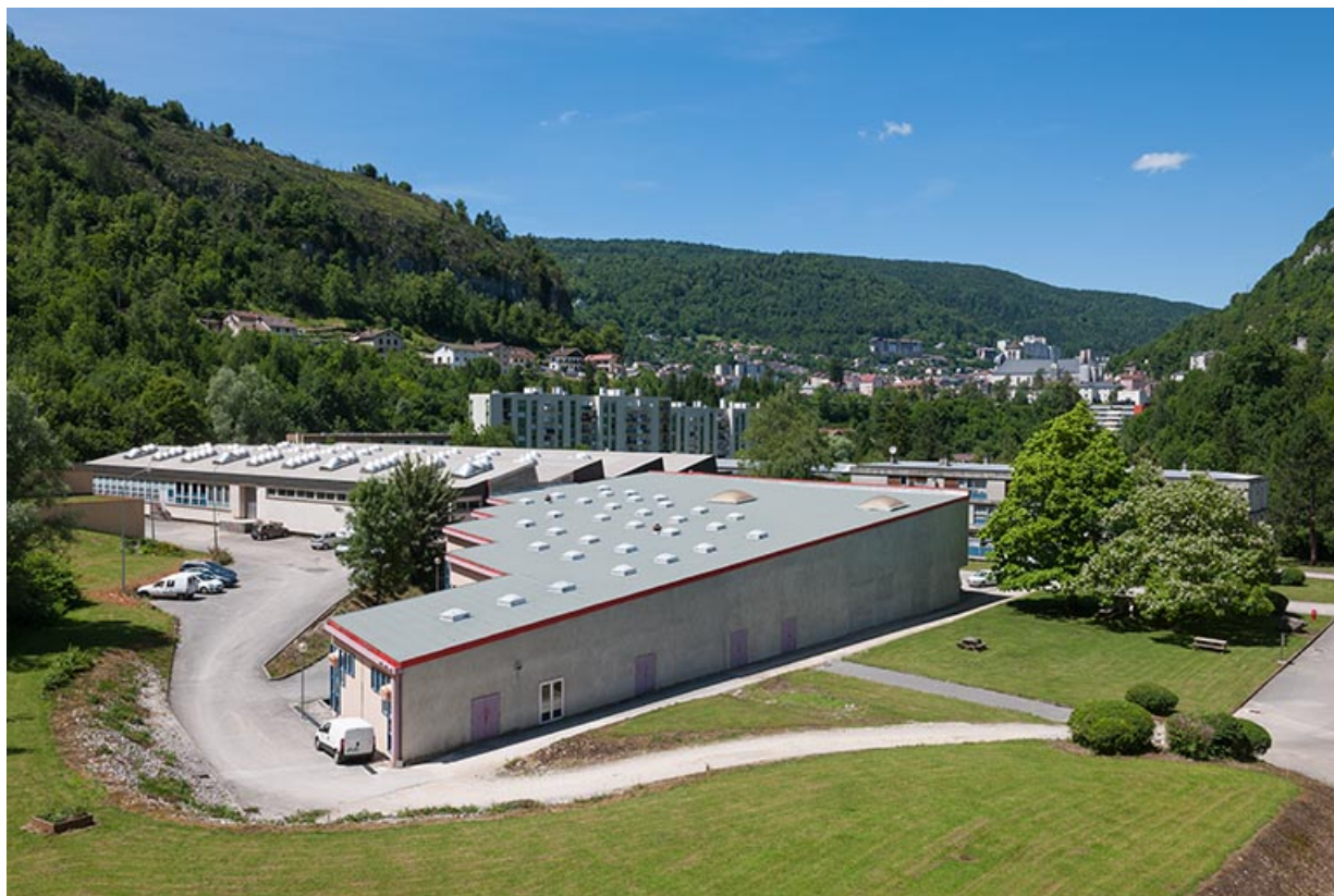
Ateliers : vue d'ensemble des toitures.
