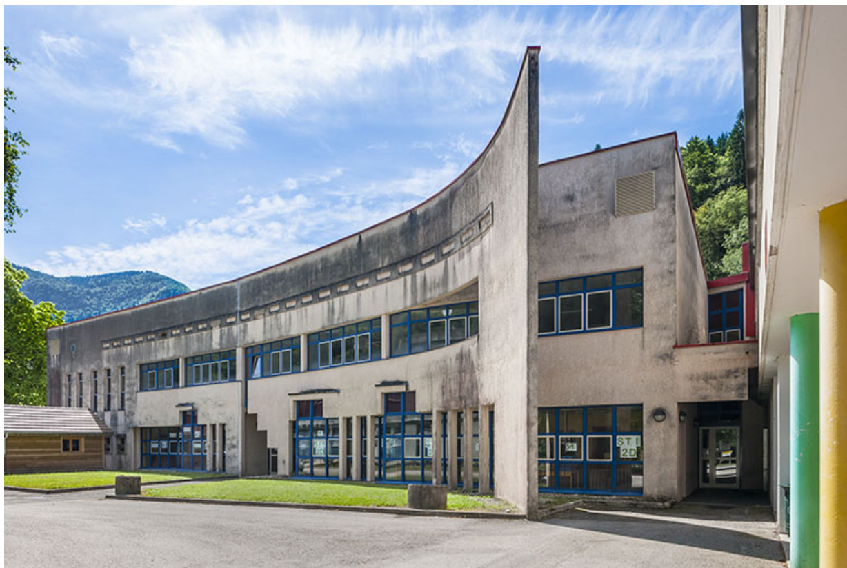
Saint-Claude, lycée de la cité scolaire du Pré Saint-Sauveur : façade de l'ancien atelier mécanique. 39, Saint-Claude rue du Tomachon
