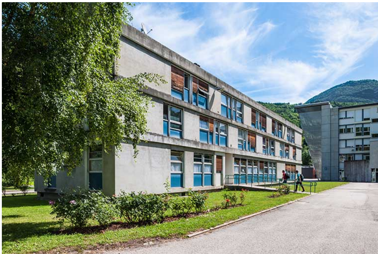
Administration : façade postérieure.
