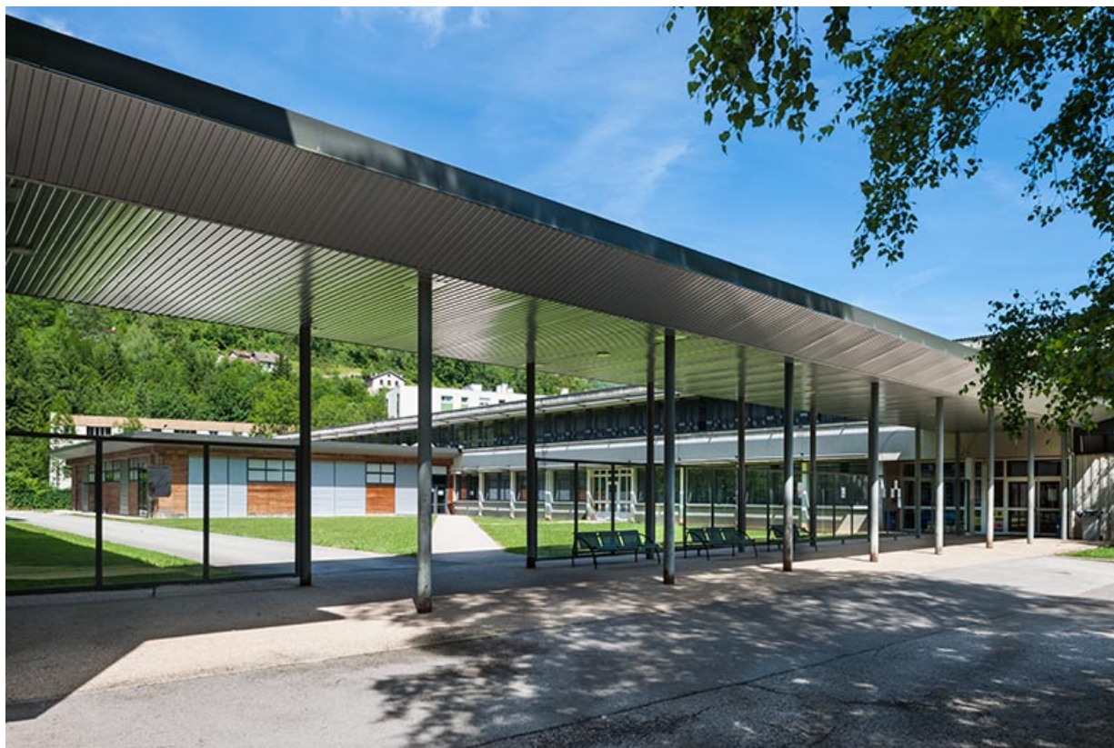
Passage couvert reliant l'atelier à l'externat tertiaire.
