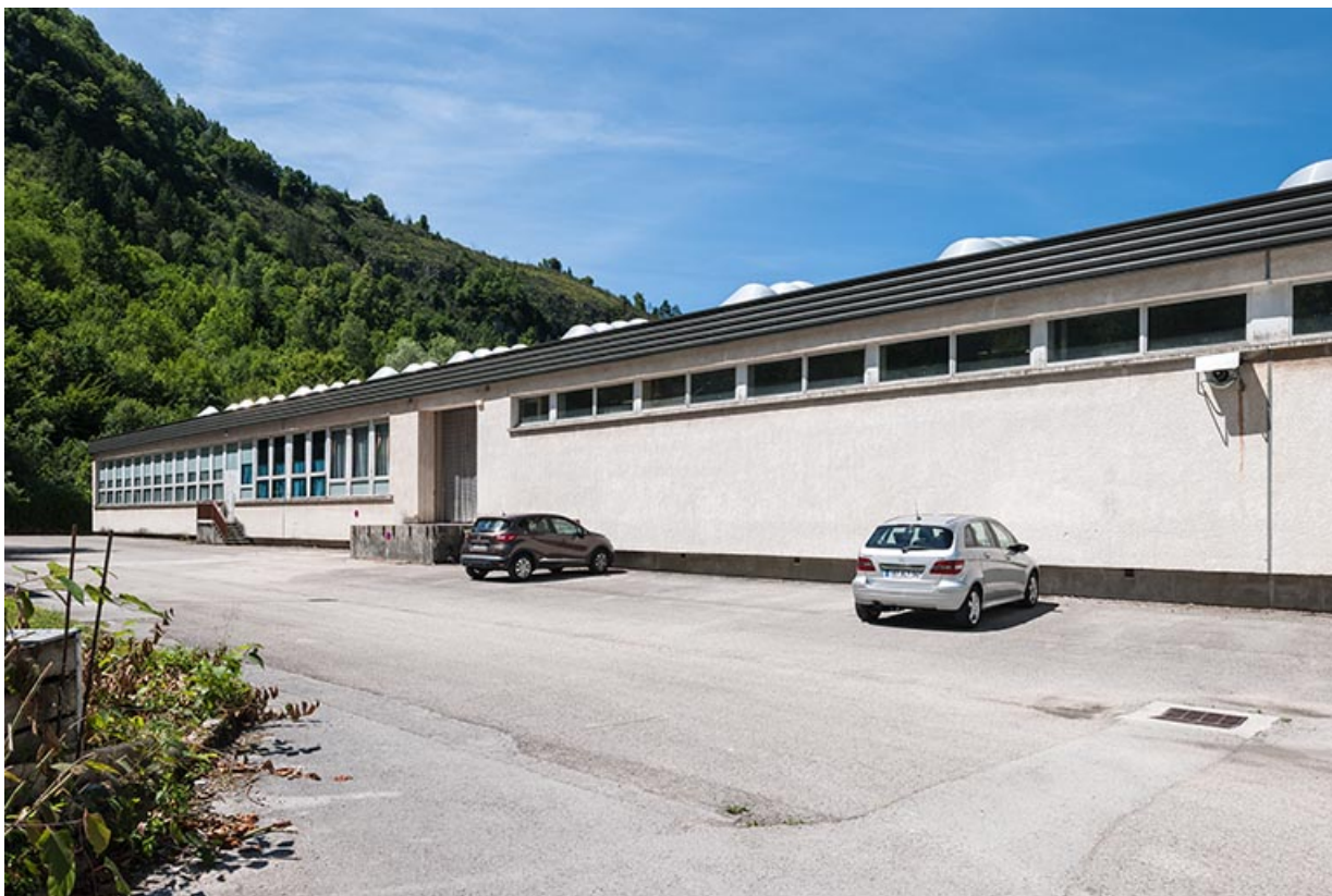
Atelier : façade postérieure.
