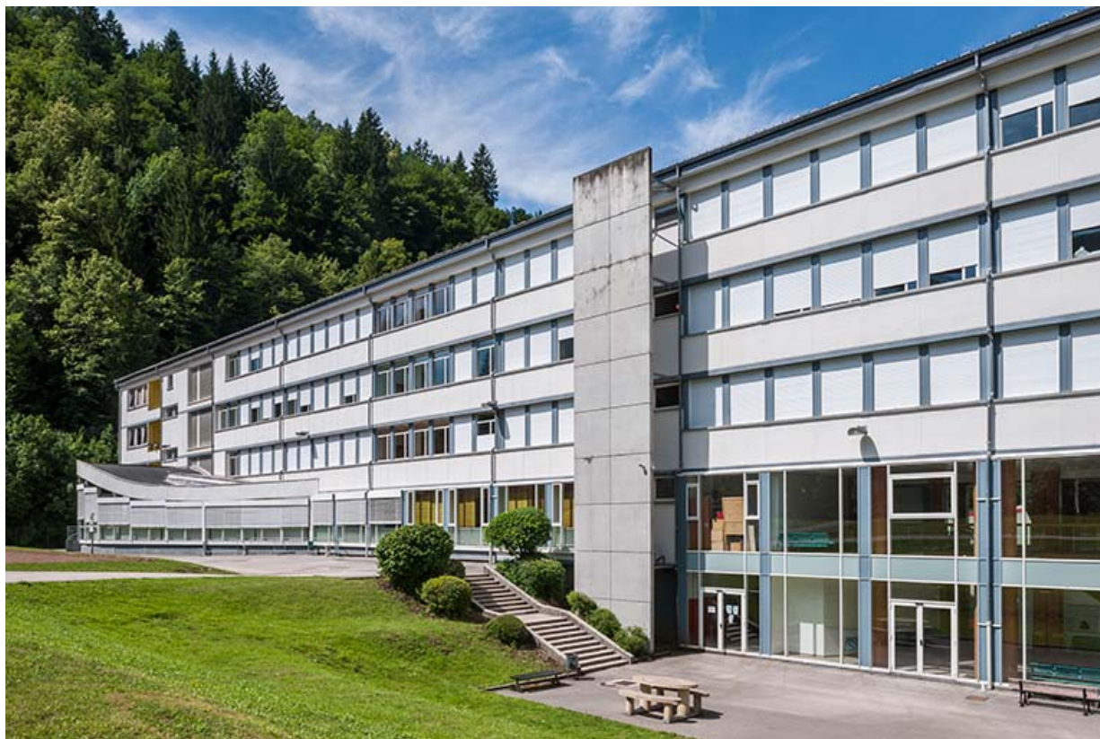
Internat : façade antérieure rénovée et aménagements extérieurs.
