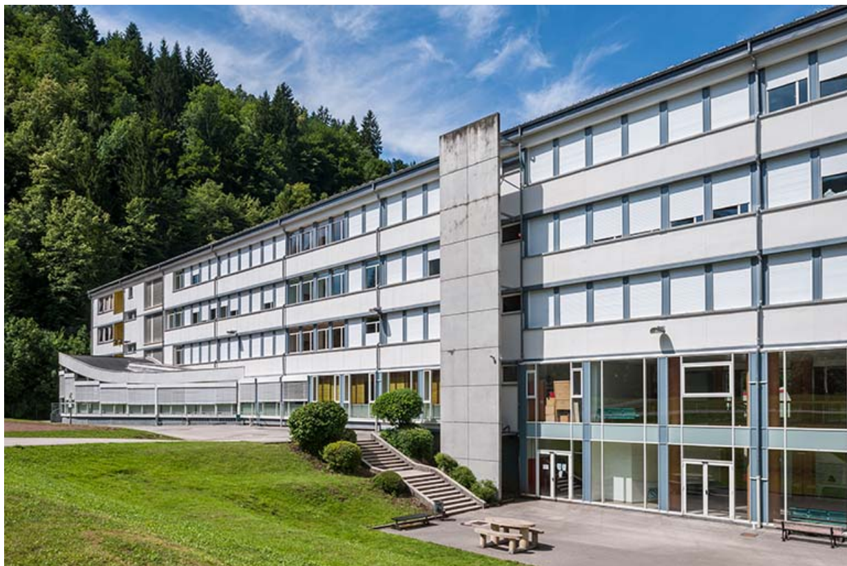
Internat : façade antérieure rénovée et aménagements extérieurs.
