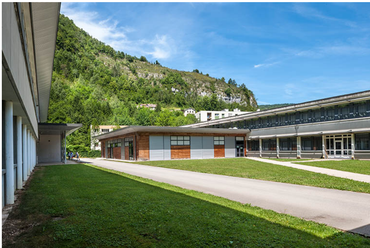
Cour entre ateliers et externat tertiaire. Au fond, l'extension du bâtiment d'externat. 39, Saint-Claude rue du Tomachon
