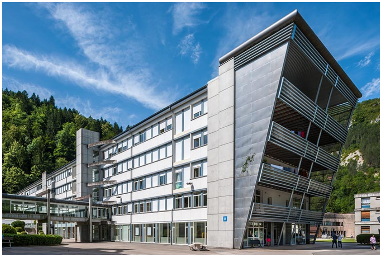
Internat : façade Est avec accroche du passage couvert vers l'externat et pignon nord avec extension. 39, Saint-Claude rue du Tomachon
