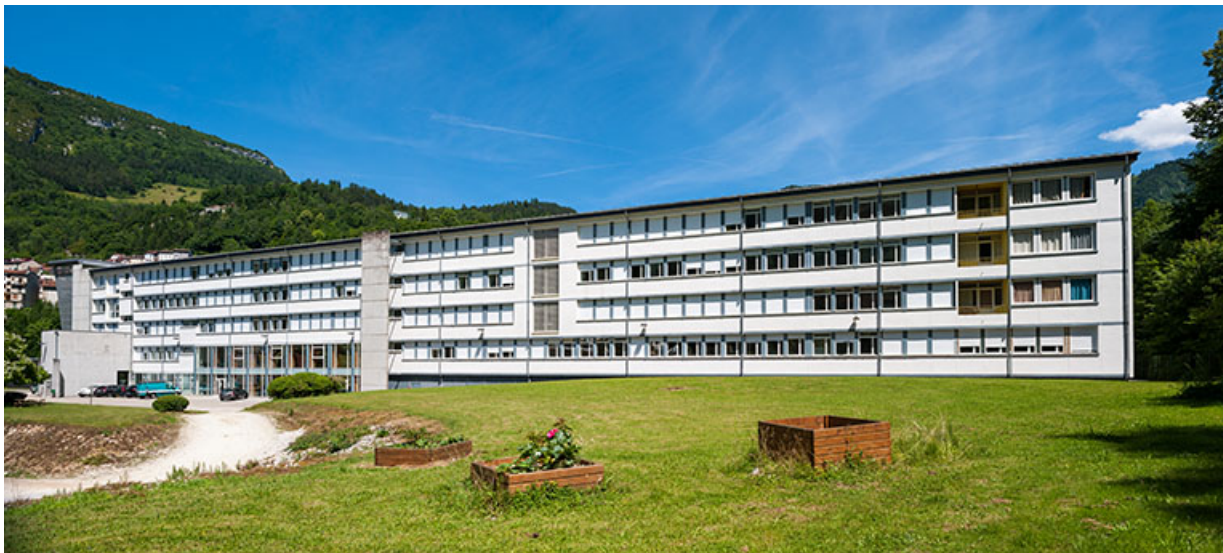
Internat : façade postérieure, vue générale.
