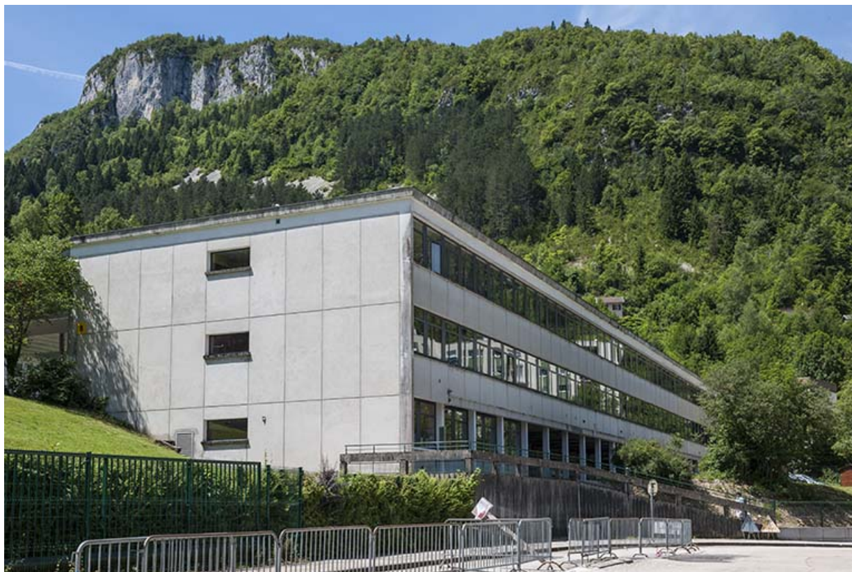
Externat : façade postérieure.
