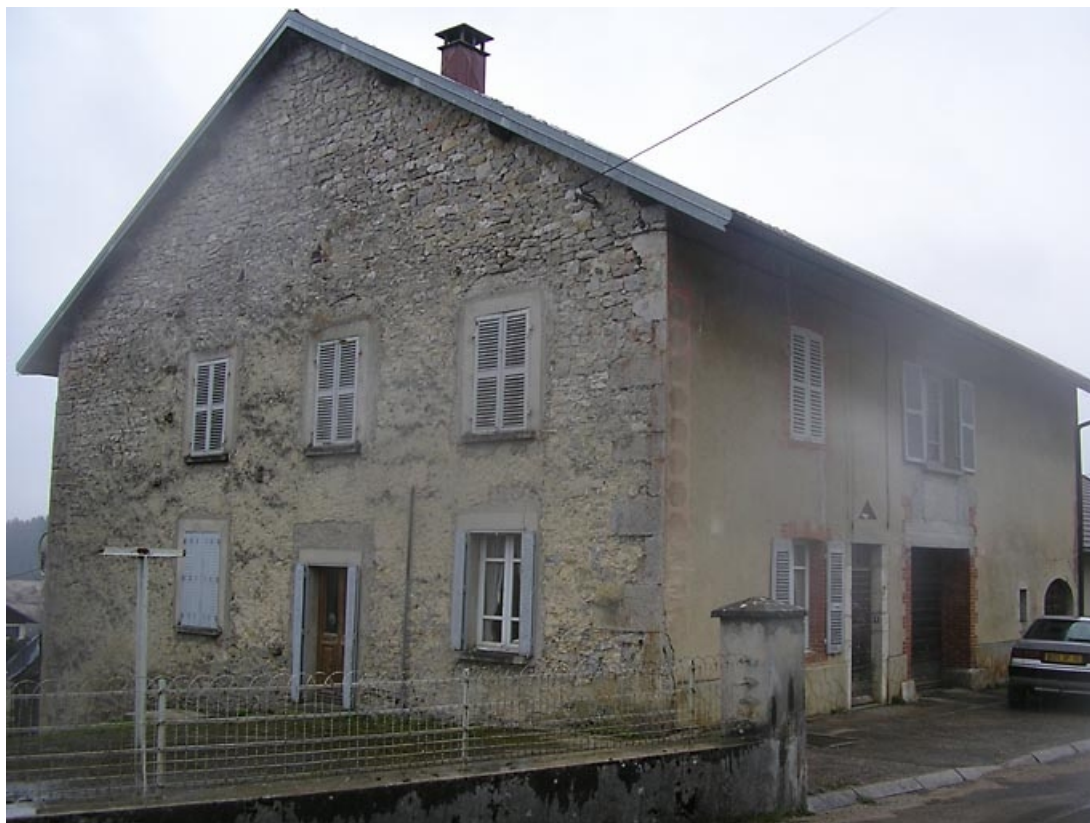
Vue de trois quarts sur pignon nord et façade antérieure.
