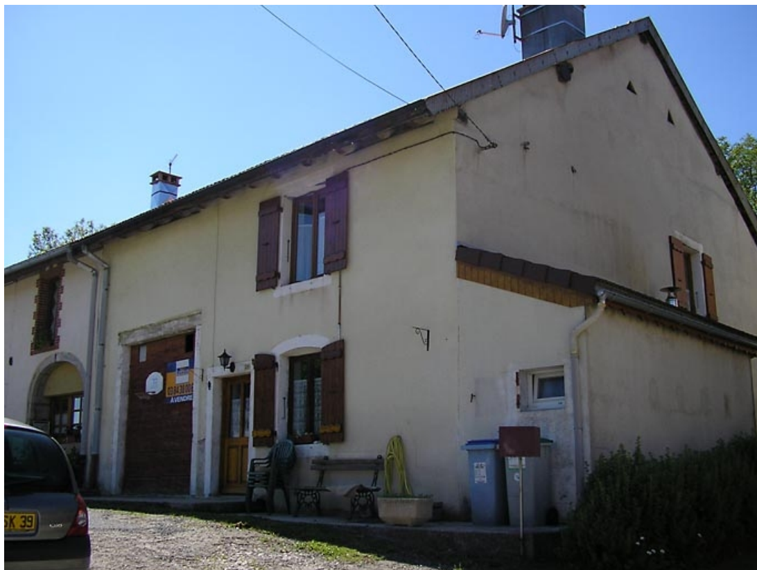
Vue de trois quarts sur façade antérieure.
