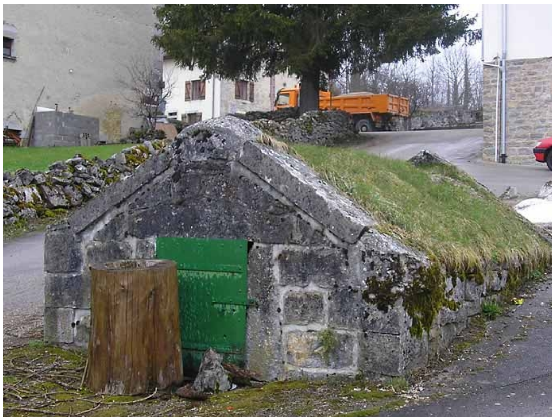
Vue de trois quarts sur ensemble hydraulique.
