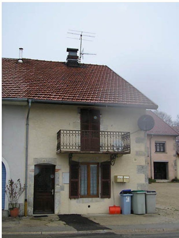
Vue générale sur façade antérieure.
