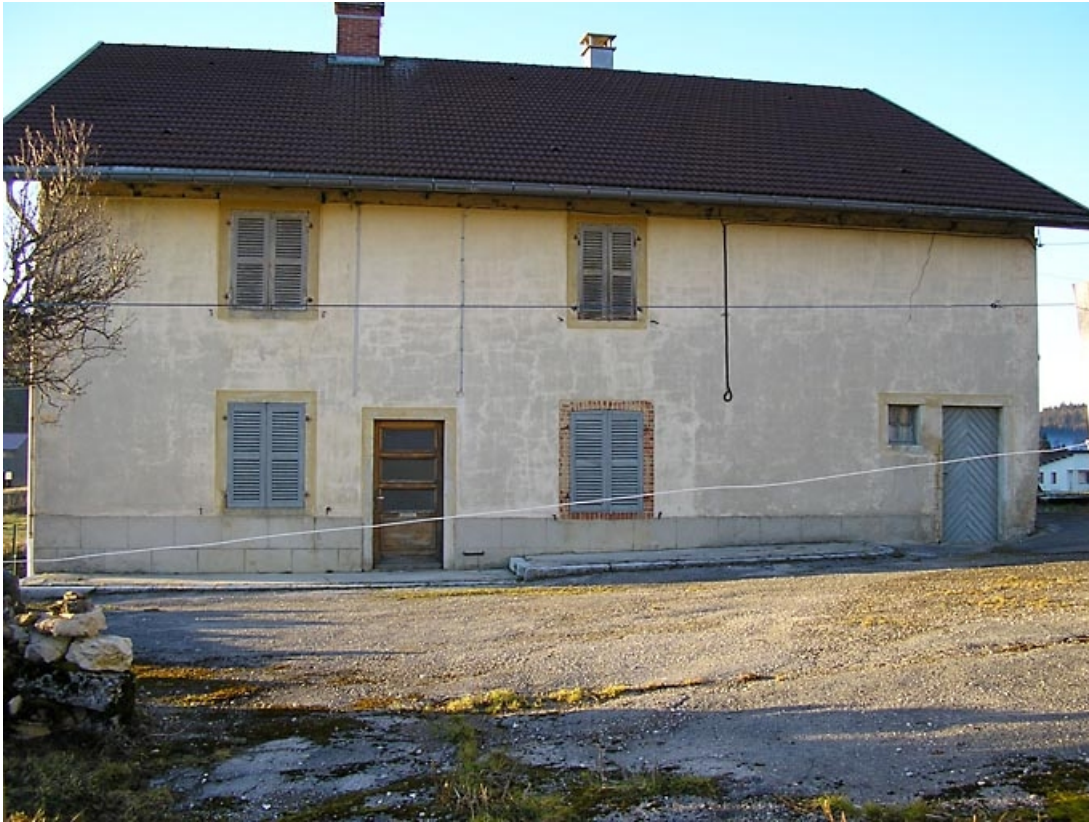
Façade antérieure. 39, Chaux-des-Prés
