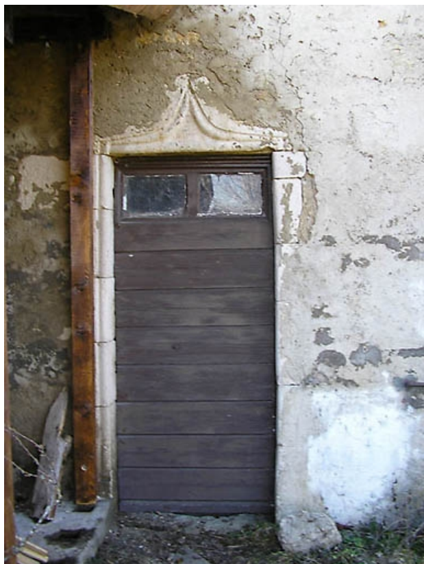
Vue de la porte avec linteau en accolade sur la façade postérieure.
