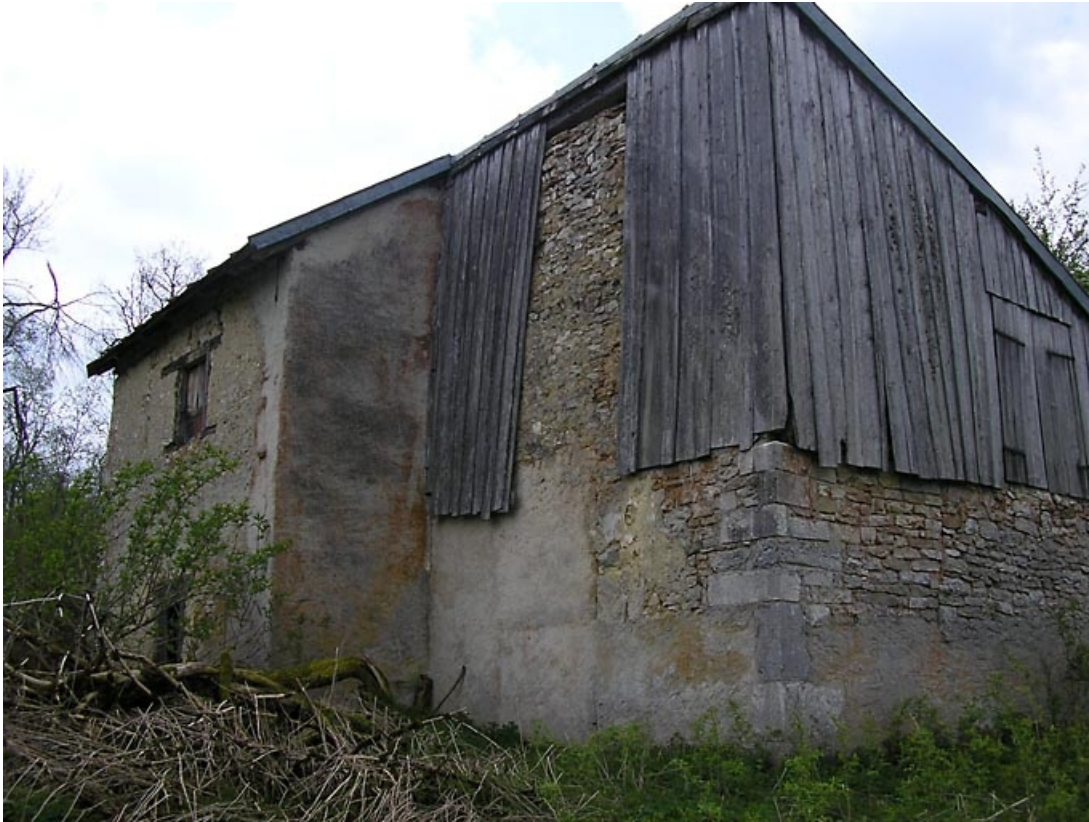
Pignon nord-est et façade postérieure vus de trois quarts.
