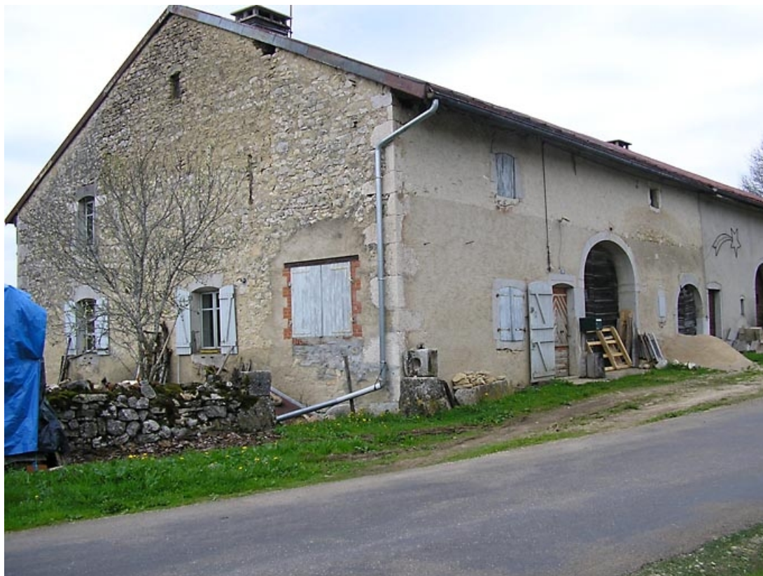
Façade antérieure et pignon nord-est vus de trois quarts. 39, Fort-du-Plasne
