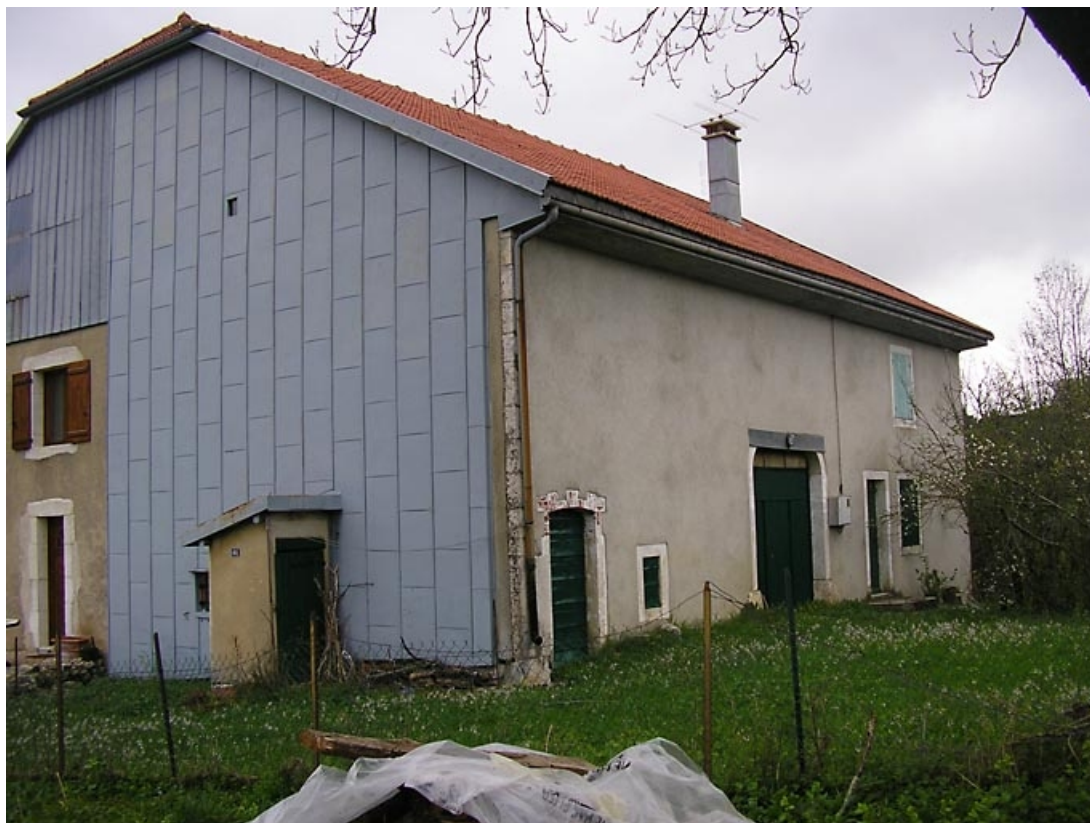
Façade antérieure et pignon essenté avec toilettes extérieures vus de trois quarts.
