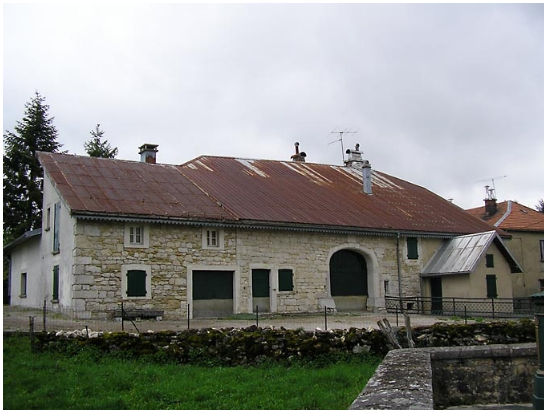
Façade postérieure et appentis vus de trois quarts.
