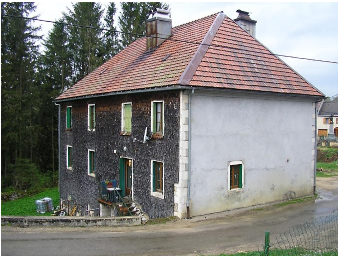
Façade postérieure sud vue de trois quarts.
