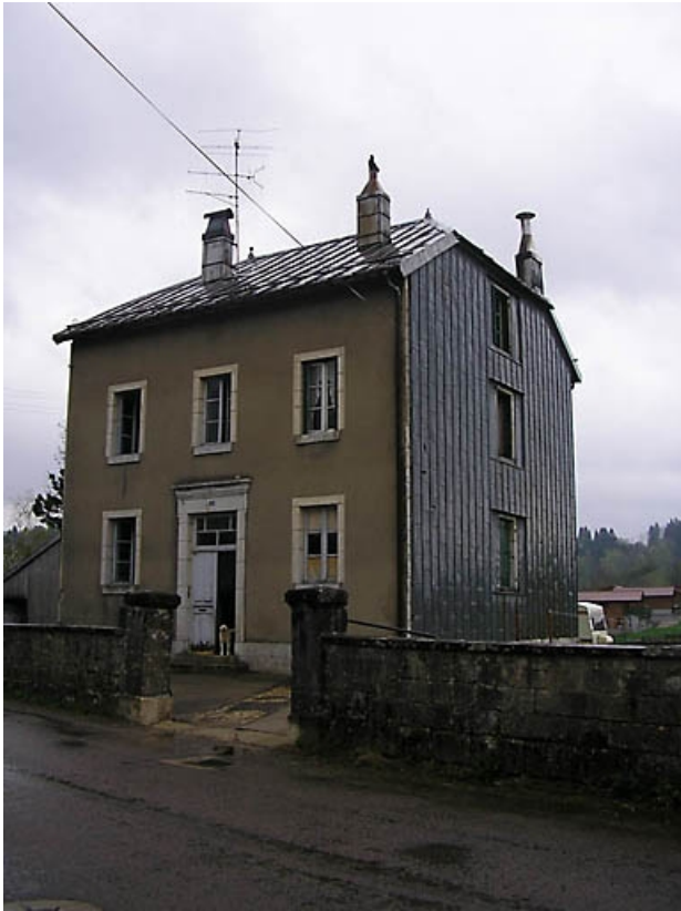
Façade antérieure et pignon sud-ouest vus de trois quarts. 39, Fort-du-Plasne
