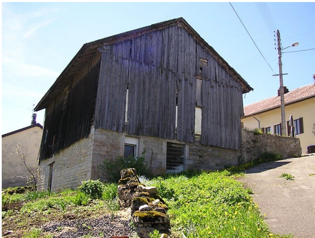
Pignon sud vu de trois quarts.
