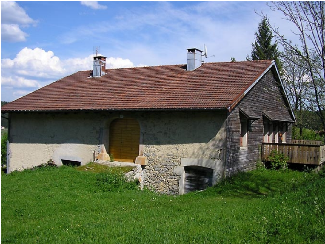
Pignon sud-ouest et façade postérieure avec pont de grange vus de trois quarts.
