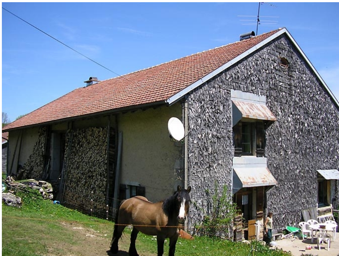
Façade postérieure et pignon sud-ouest vus de trois quarts.
