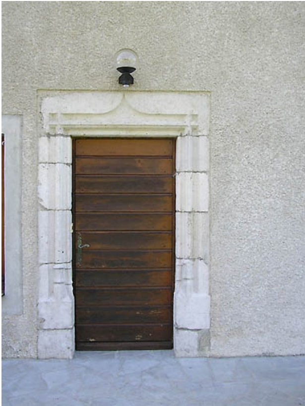
La porte et son linteau avec arc en accolade.
