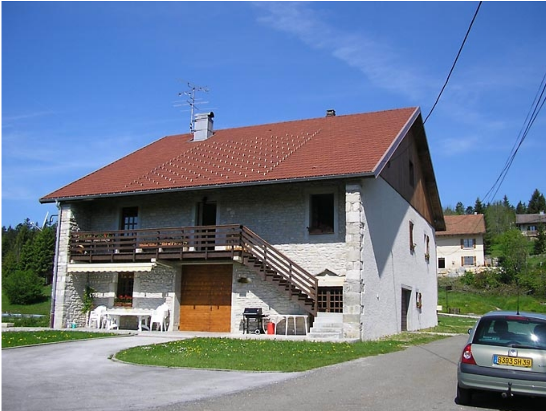
Façade postérieure et pignon sud-ouest.
