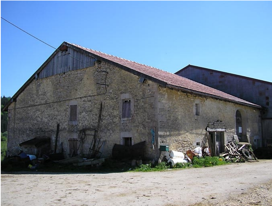
Façade postérieure et pignon essenté vus de trois quarts. 39, Prénovel les Janiers
