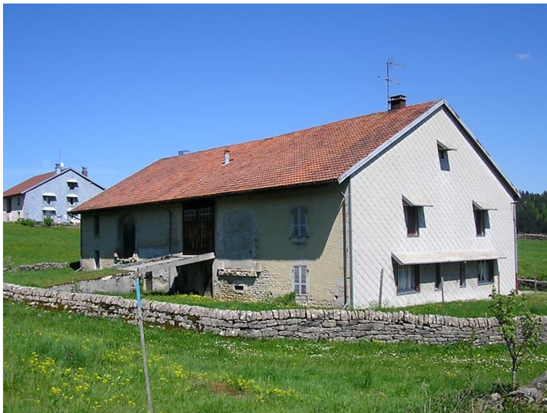
Vue de trois quarts du pignon sud-ouest et de la façade postérieure avec pont de grange.
