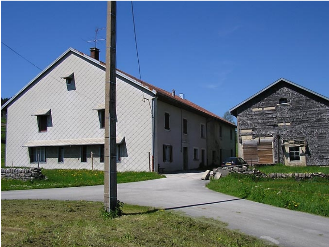
Pignon sud-ouest vu de trois quarts.
