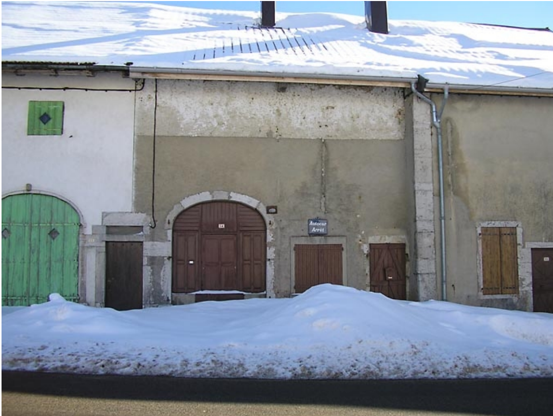
Façade antérieure. 39, Grande-Rivière
