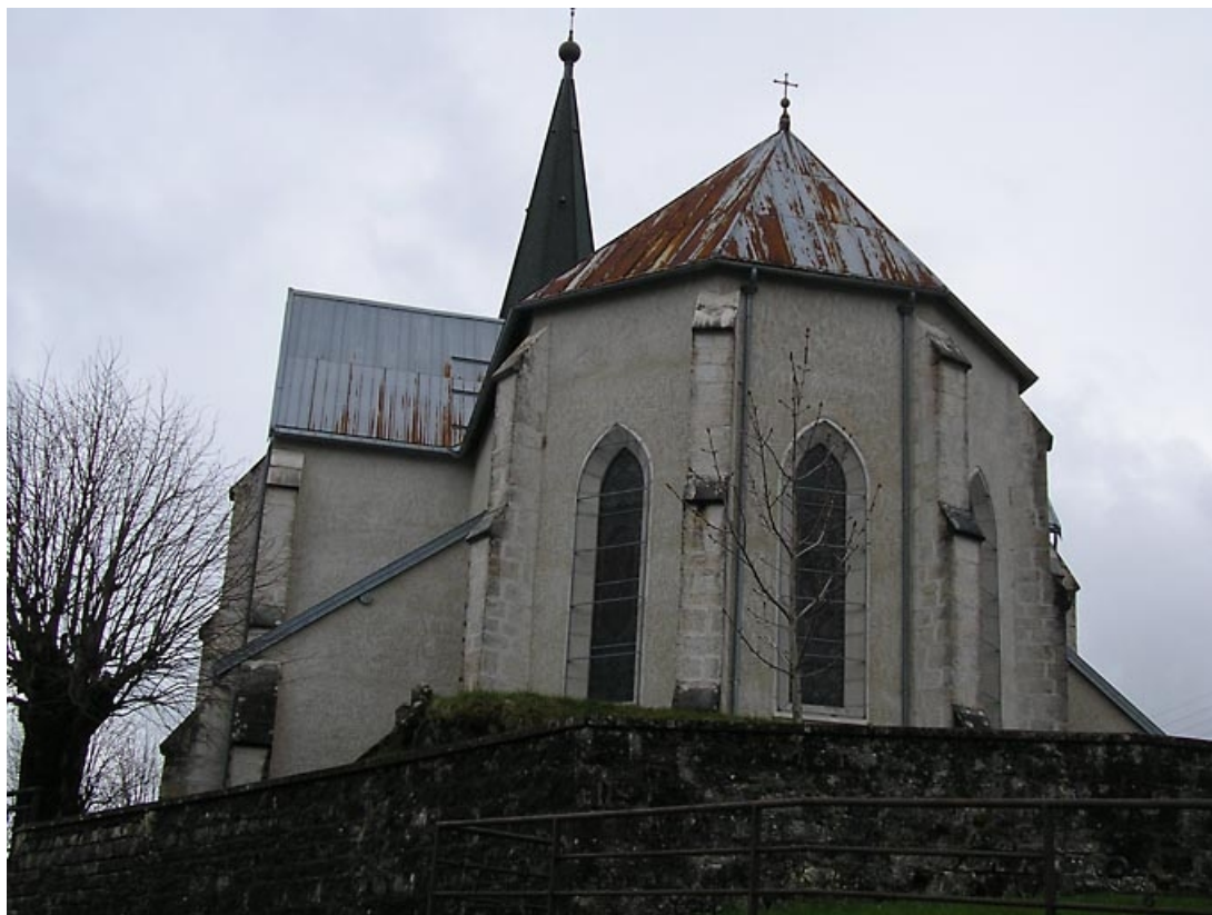
Vue de l'abside et du bras sud du transept.
