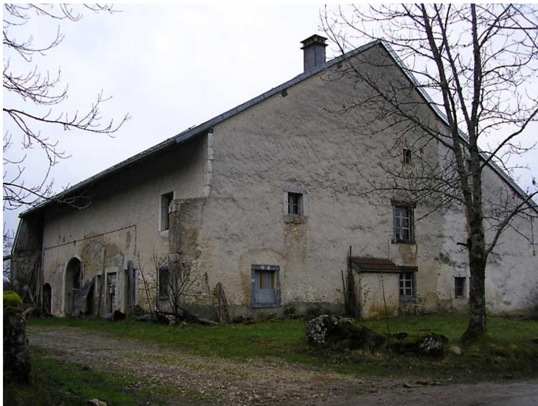
Pignon nord-est et façade antérieure vus de trois quarts.
