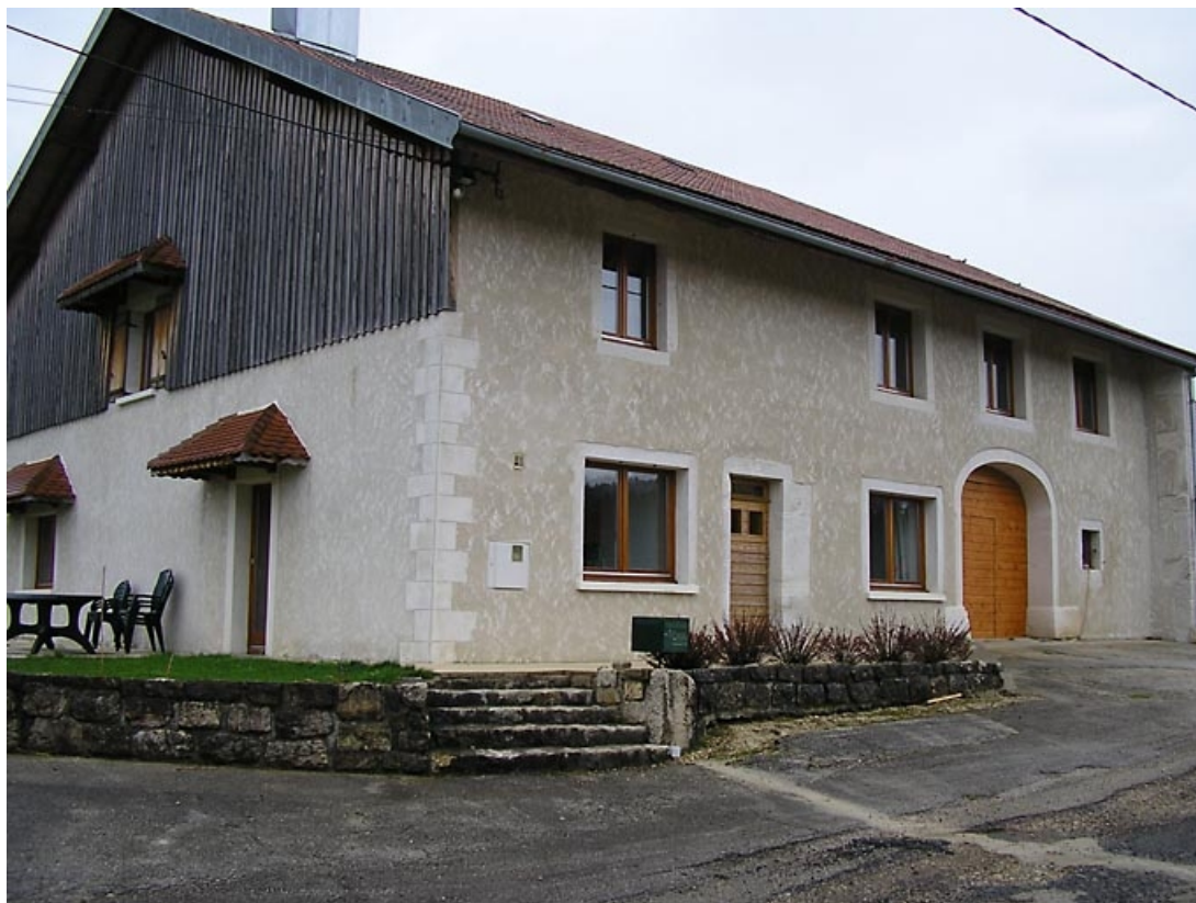
Façade antérieure et pignon sud-ouest vus de trois quarts. 39, Lac-des-Rouges-Truites, 68 les Martins, lieudit : les Martins
