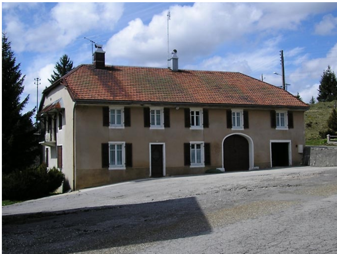
Façade antérieure et pignon nord vus de trois quarts.
