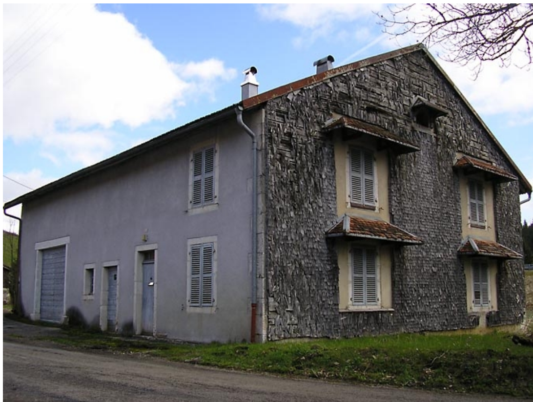
Pignon sud et façade antérieure vus de trois quarts.
