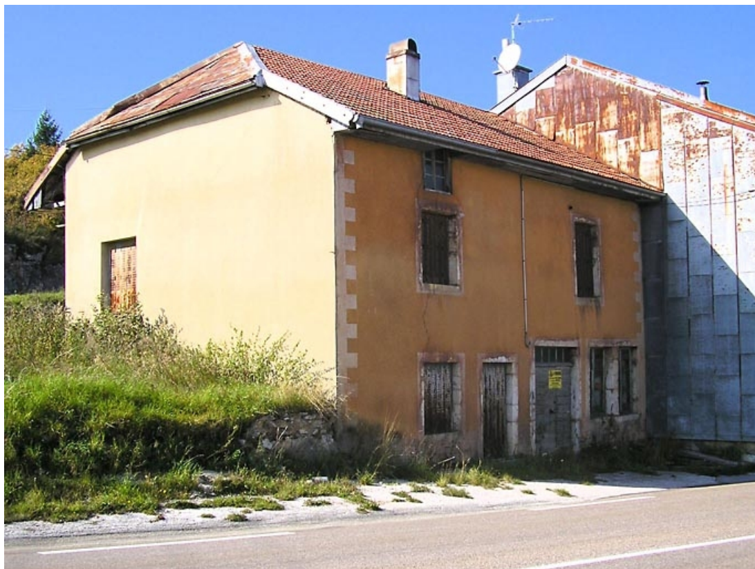
Façade antérieure et pignon est vues de trois quarts.
