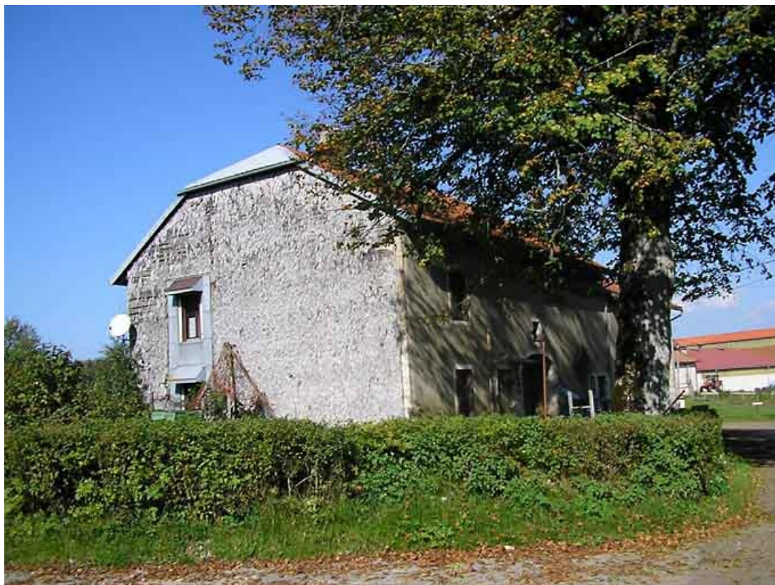
Pignon sud-ouest vu de trois quarts.
