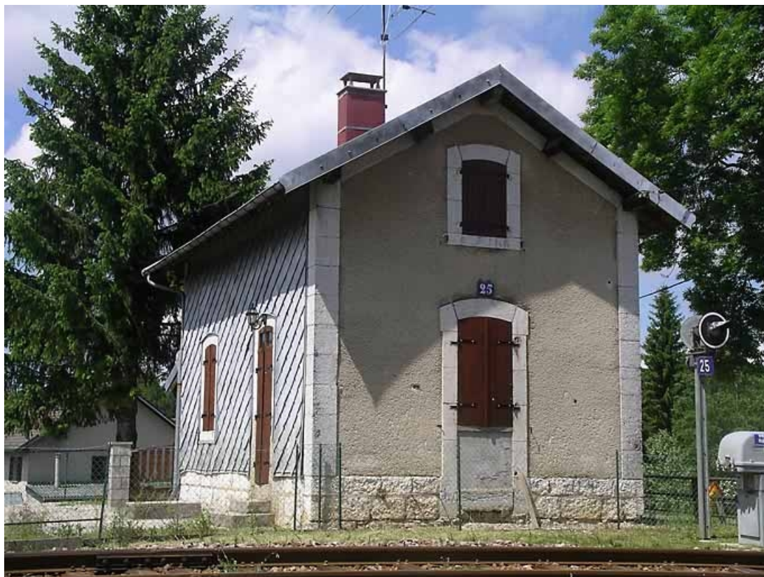
Pignon et façade antérieure vus de trois quarts.
