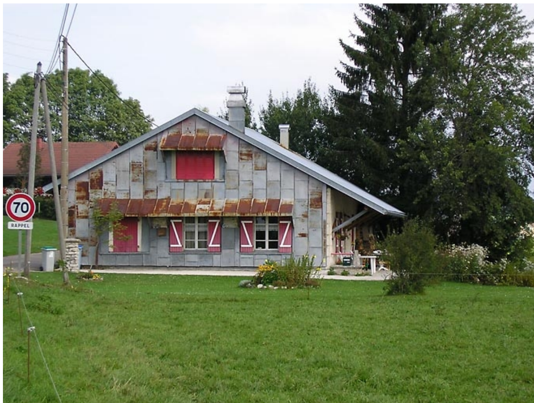
Vue de la façade sud-ouest.
