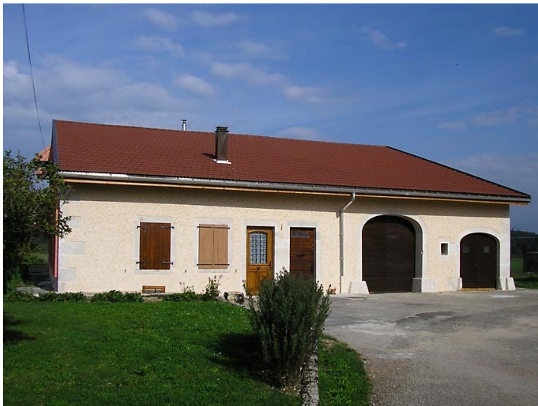
Vue latérale de la façade antérieure.
