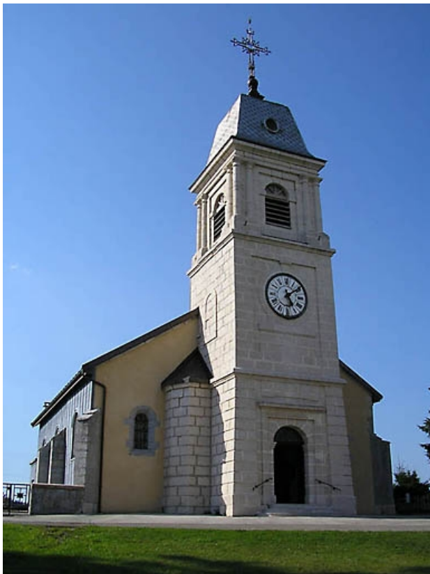
Vue générale de la la façade antérieure, des bas-côtés et du clocher.
